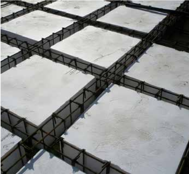
Blocos de EPS numa cofragem de betão armado aligeirada
