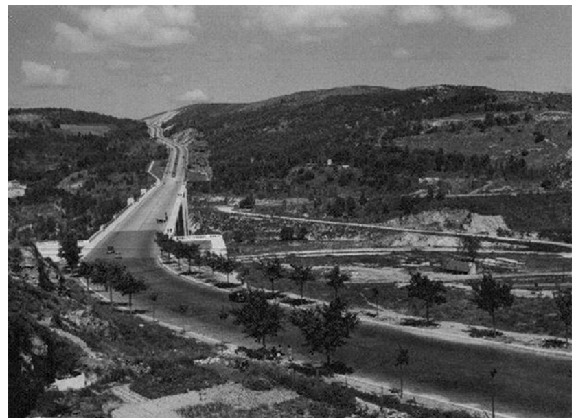
118. Viaduto Duarte Pacheco | A5, 1944. Fonte: Arquivo Fotográfico da C.M.Lisboa
