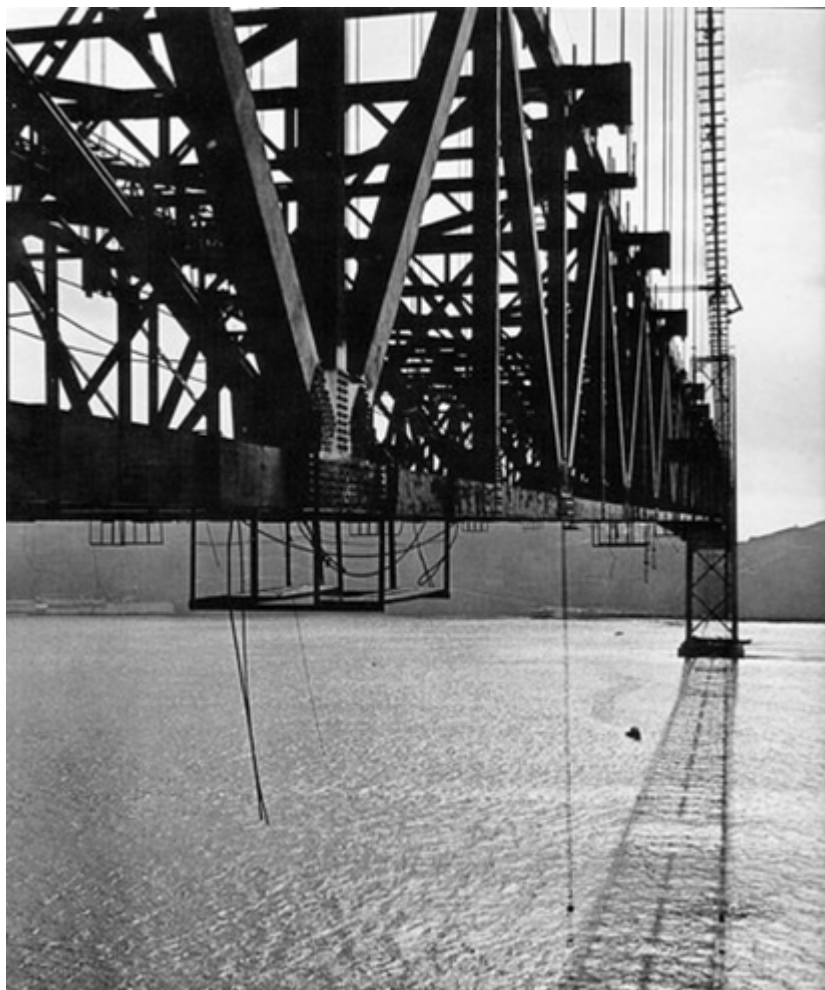
122. Construção da Ponte 25 de Abril, 1966. Fonte: Arquivo Fotográfico da C.M.Lisboa
