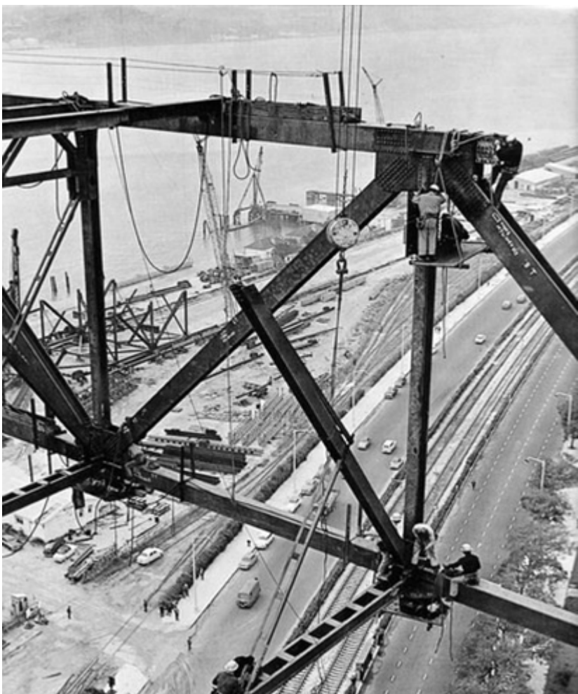
125. Construção da Ponte 25 de Abril, 1966. Fonte: Arquivo Fotográfico da C.M.Lisboa
