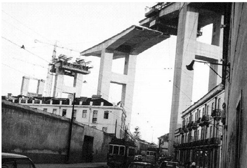
121. Construção da Ponte 25 de Abril, 1966. Fonte: Arquivo Fotográfico da C.M.Lisboa
