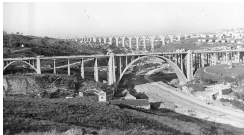
102. Eixo Norte-Sul I Viaduto Eduardo Pacheco, 1966. Fonte: Arquivo Fotográfico C.M.Lisboa
