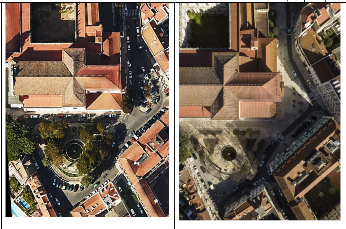
Figuras 18 e 19 – Largo da Graça: Zona do adro do convento da Graça, antes e depois da obra (à esquerda Google Earth Pro 2012 e à direita FG+SG Fernando Guerra, 2017).
