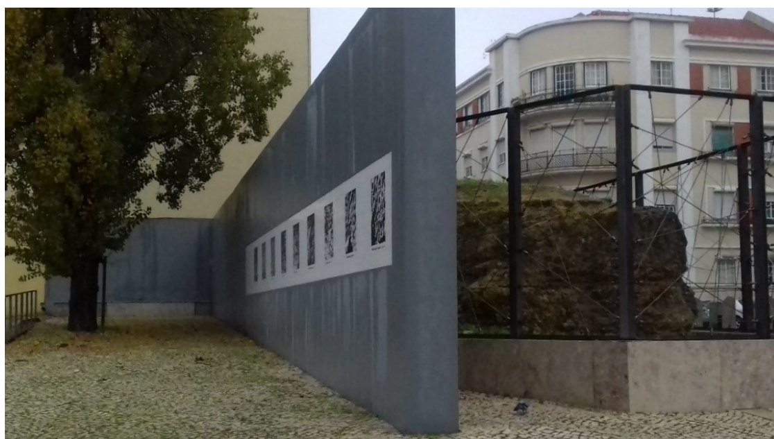
Figura 4 - Geomonumento da Rua Sampaio Bruno Imagem dos Briozoários sobre painel de azulejos, na traseira do geomonumento (Fonte: CML, 2021)
