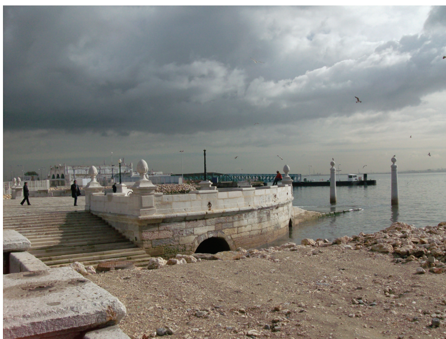
Fig. 39 - Vista para o rio Tejo após a reposição do Cais das Colunas, 21.01.2009
