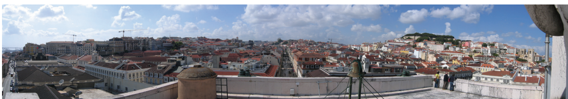
Fig. 6 - A envolvente da Praça: a Baixa Pombalina, vista a partir da cobertura do Arco da Rua Augusta
