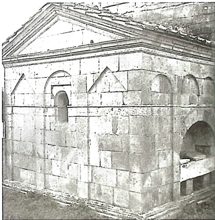
Vista externas de S. Frutuoso onde se pode observar o arcosólio.
