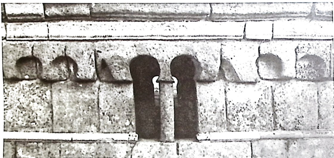
Pormenor da arca-tura sob a cornija da torre lanterna.
