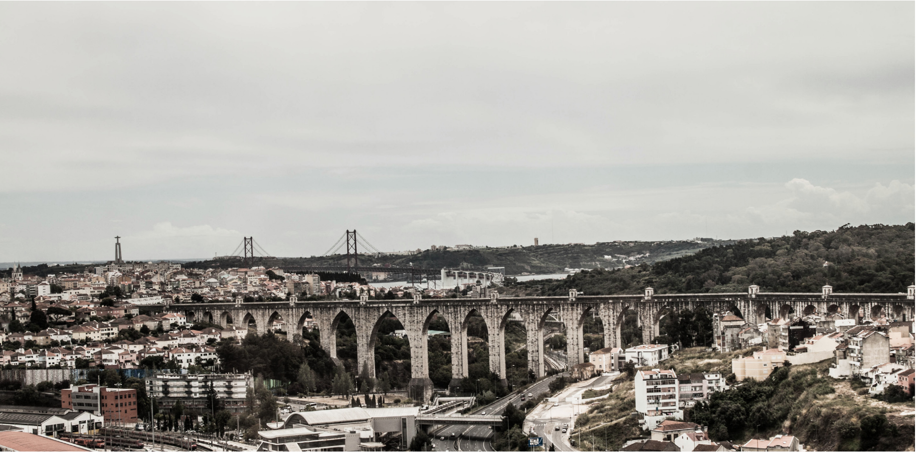
i31 fotografia sobre o vale de Alcântara
