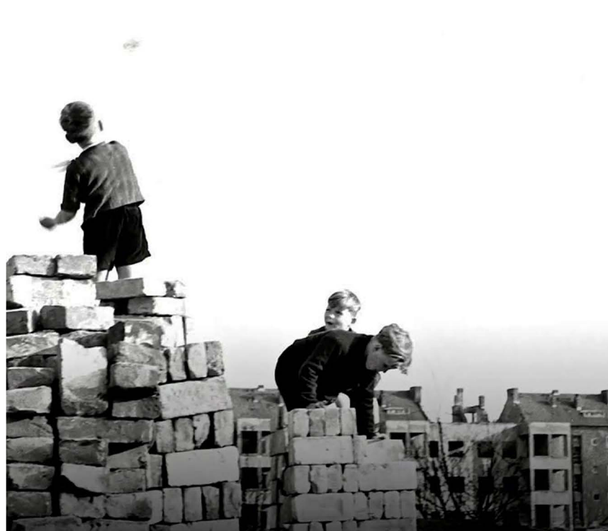
016 - Axel Springer Nebau - Trümmerkinder; Das Fundament.
