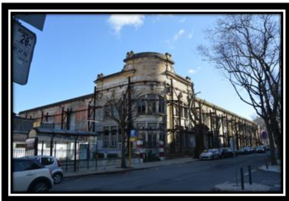
Figura 14 – Fachada em L 54 .
