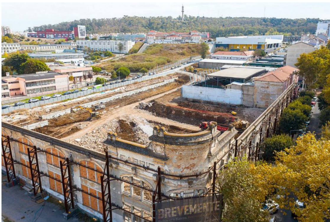
Figura 44 – Início das obras do Projeto Fábrica 1921 155 .
