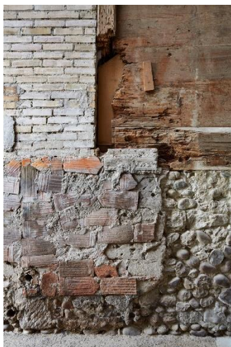
Figura 7 – Layers. Detalhe de obra do Atelier Freiluft. Suíça. © David Aebl
