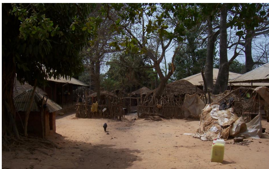
Entrada do hospital tradicional
