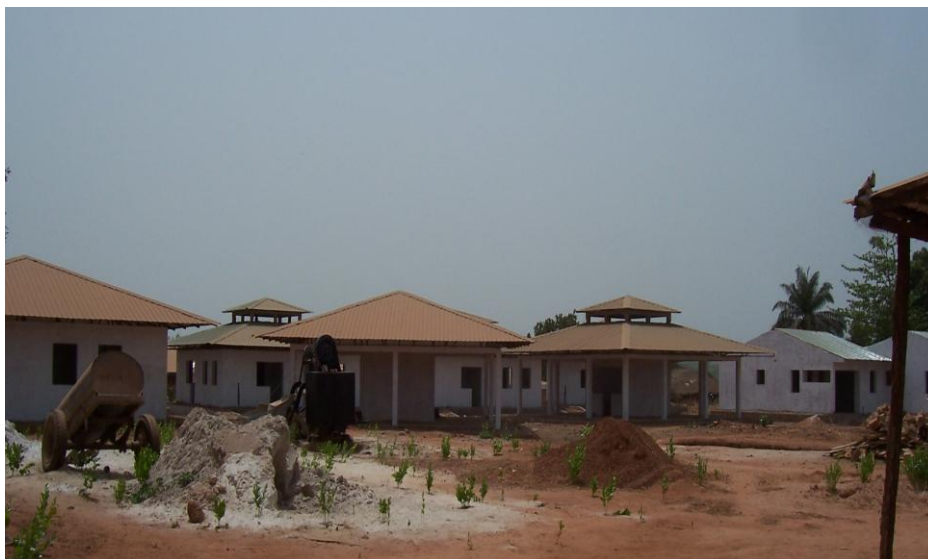
Visão do novo hospital psiquiátrico no bairro do Enterramento
