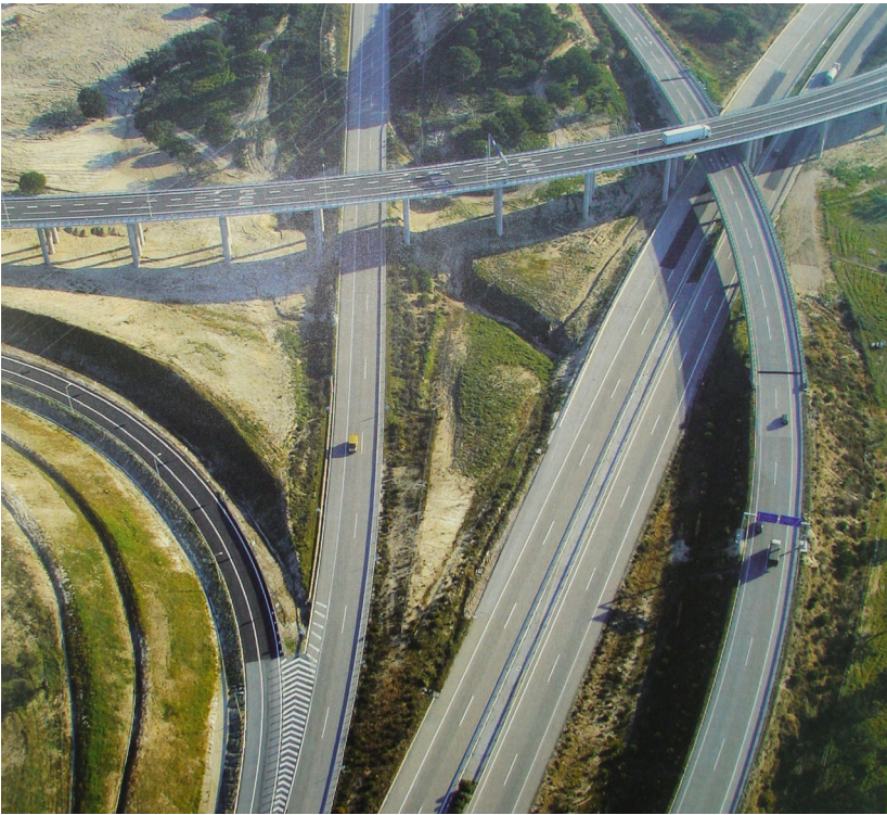
08 Infraestruturas viárias © Arquivo Brisa
