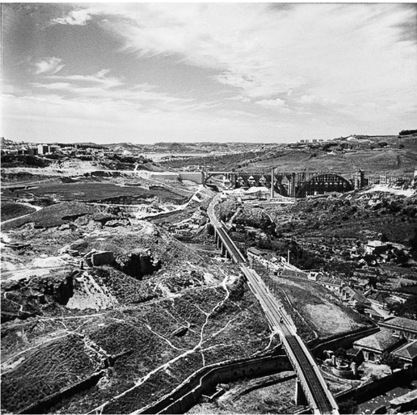
38 Construção de infraestruturas
