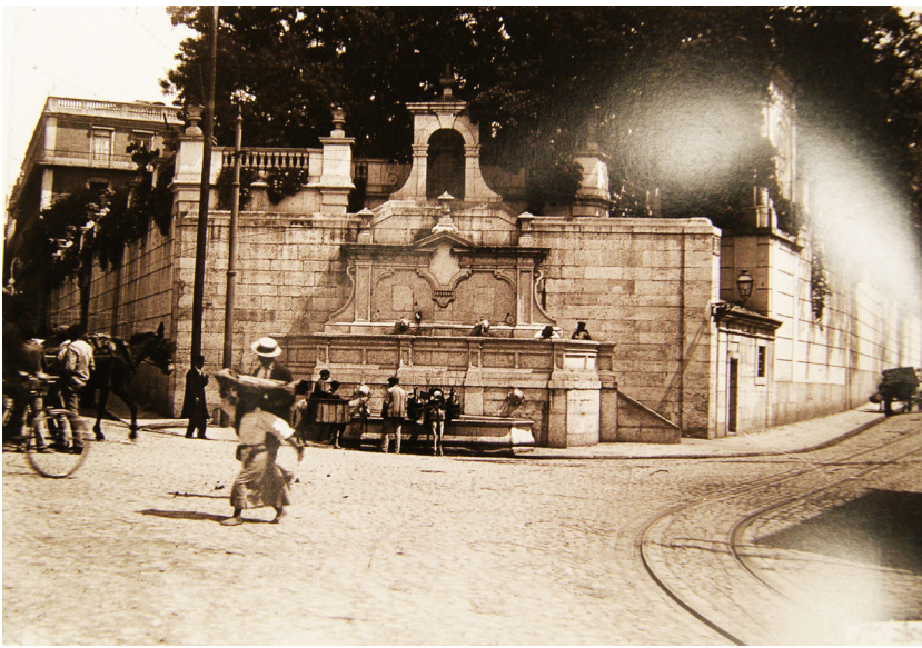
36 Chafariz do Rato © " Lisboa e o Aqueduto "
