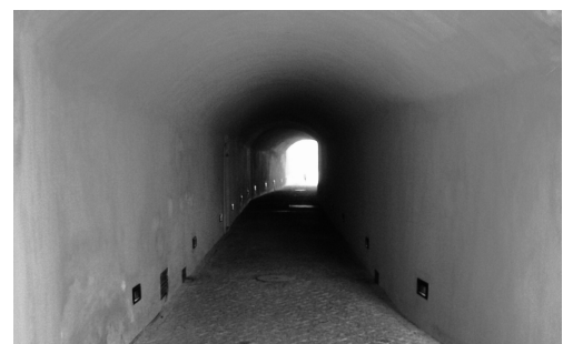
Figura 02 _ Túnel | Forte Monte Cintra
