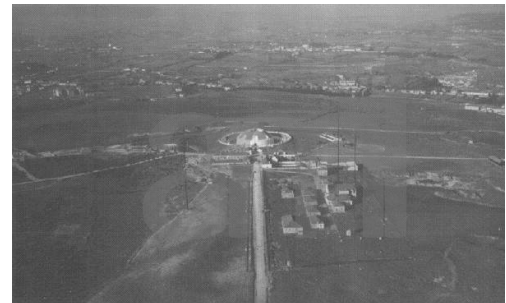
Figura 09 _ Vista aérea do Forte de Monsanto (1930)
