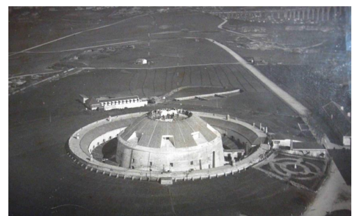
Figura 10 _ Vista aérea do Forte de Monsanto
