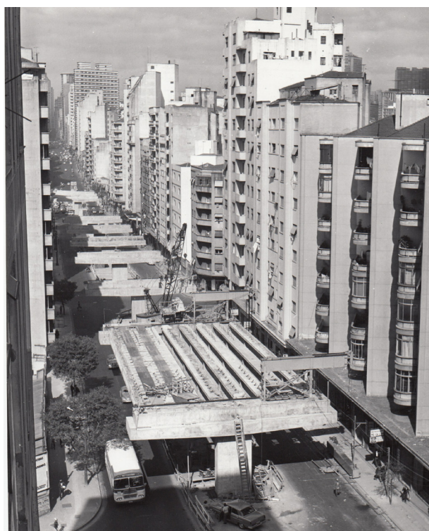
25. Costruzione del viadotto Minhocão, San Paolo ,Brasile, 1970, G.C.Rios.
