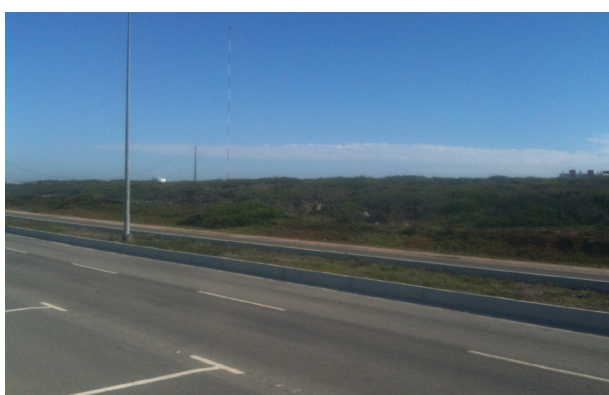
42. LINEE - nei pressi delle pipelines di Sines, foto dell'autore, ottobre 2015
