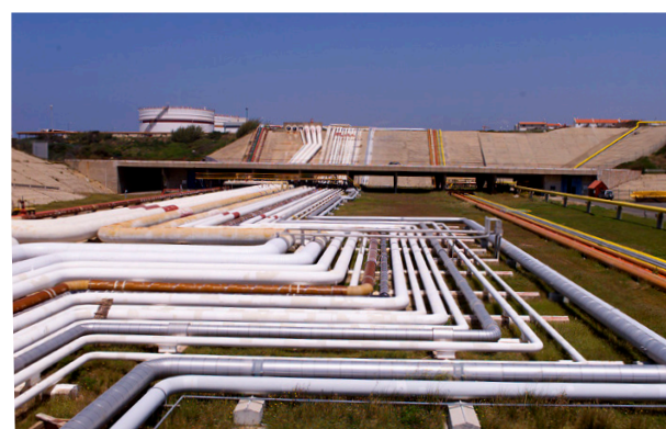
18. Costruzione di un pipeline interrato, civilarc.com
