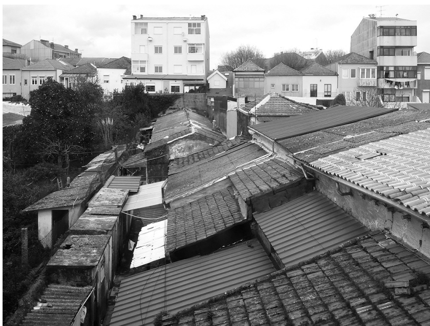
Fig. 38 Ilha na rua São Victor 172, Porto.
