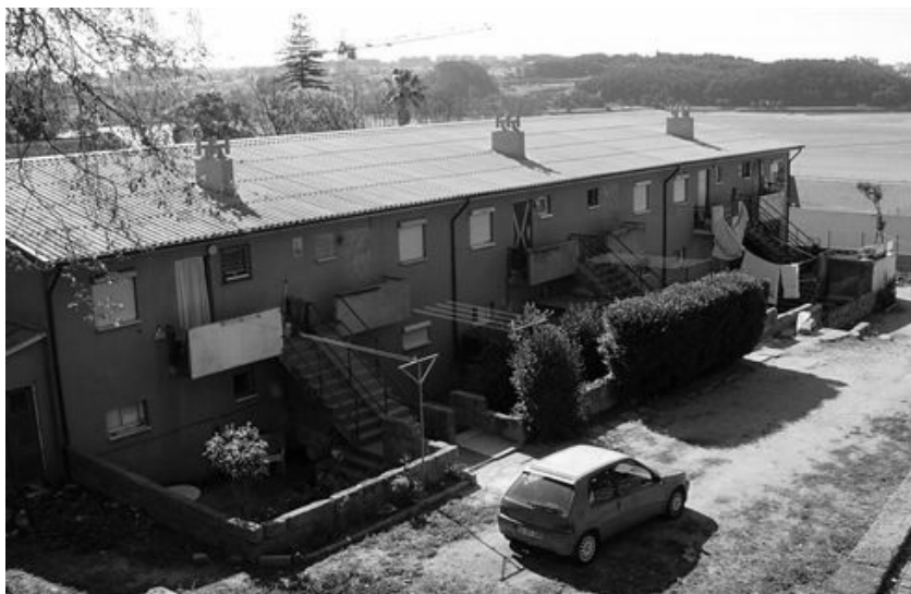
Fig. 36 Conjunto de Habitação Municipal, Bairro Rainha D. Leonor, Porto. Edifícios antes da intervenção
