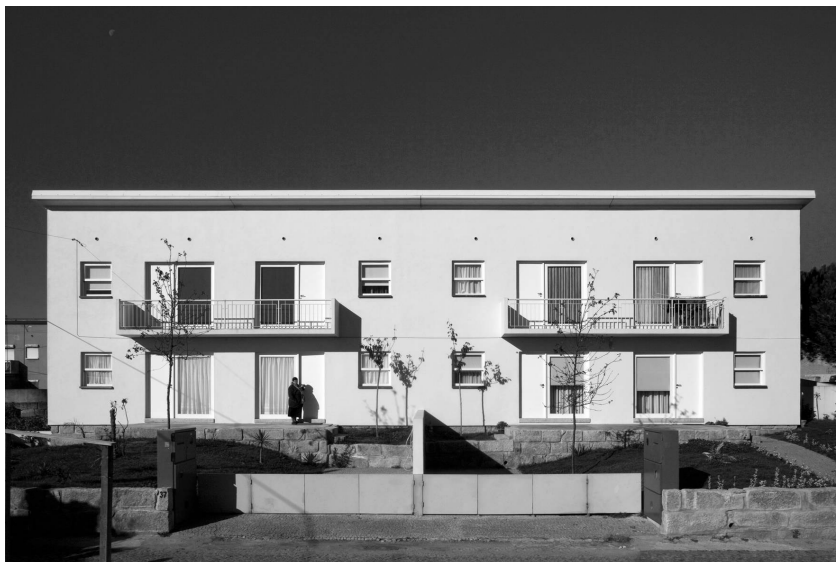
Fig. 37 Conjunto de Habitação Municipal, Bairro Rainha D. Leonor, Porto. Inês Lobo Arquitectos, 2005-2013. Edifícios antes da intervenção.
