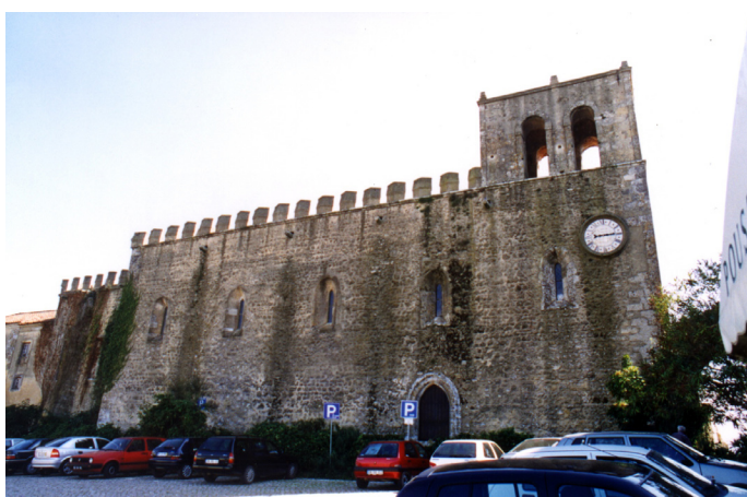
Igreja de Santiago de Palmela, compreendendo o túmulo de D. Jorge (1481-1550), último mestre da Ordem de Santiago (Palmela)
