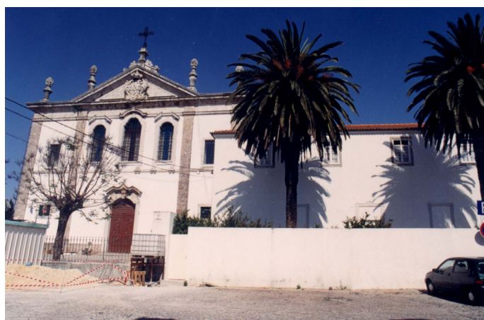
Igreja Paroquial de São Sebastião / Igreja do antigo Convento de São Domingos, incluindo parte do claustro anexo à Igreja (Setúbal)
