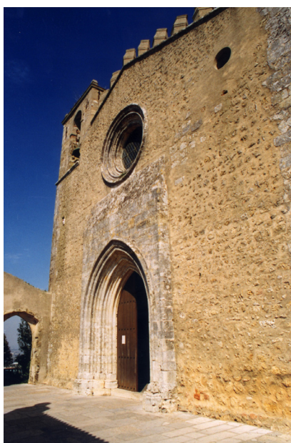
Igreja de Santiago de Palmela, compreendendo o túmulo de D. Jorge (1481-1550), último mestre da Ordem de Santiago (Palmela)
