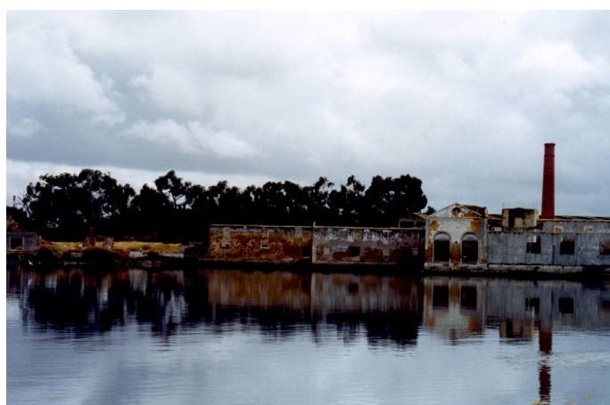
Moinhos de maré existentes no Seixal - Moinho de Maré Velho do Breyner
