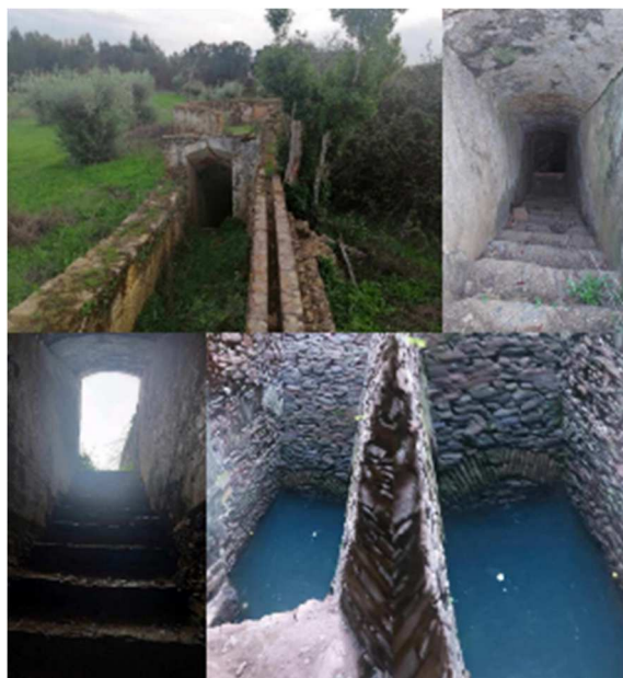
Figura 41. Galeria: construção romana, Alandroal, 2022.
