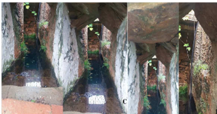
Figura 39. Galeria Subterrânea 220 metros S Igreja Nossa Senhora das Mártires, 2022.
