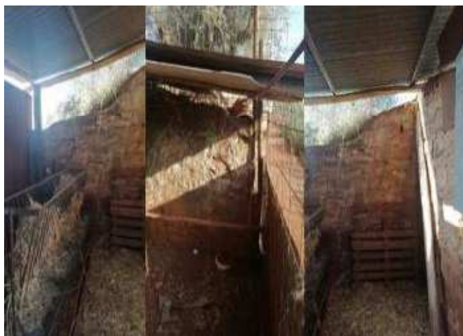
Figura 57. Tanque dos Mouros, Contrafortes – lateral sul, 2023.
