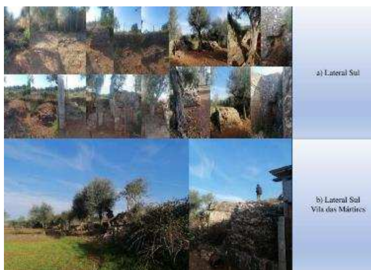
Figura 56. Tanque dos Mouros Contrafortes: a) lateral sul; b) lateral Mártires, 2024.
