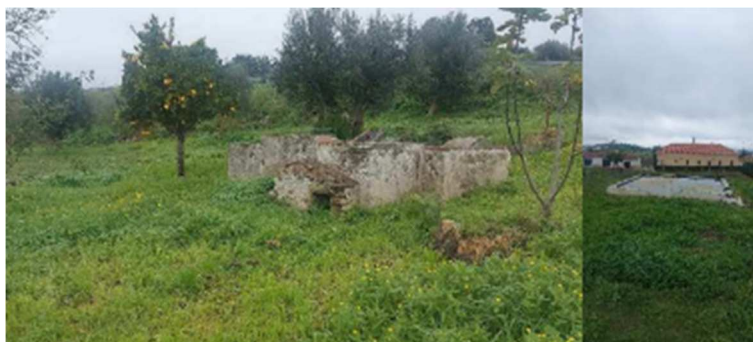
Figura 47. Tanques Vila das Mártires, 2024.
