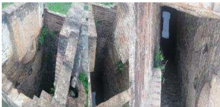
Figura 43. Estrutura poço romano, Alandroal, 2022.
