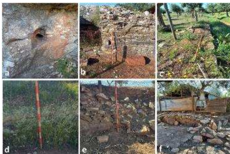
Figura 28.: a) Orifício 12 cm diâmetro; b) espaço entre contrafortes; c) início Aqueduto; d) Parte alta do Aqueduto; e) f) Dispersão e destruição do Aparelho Construtivo – opus incertum .
