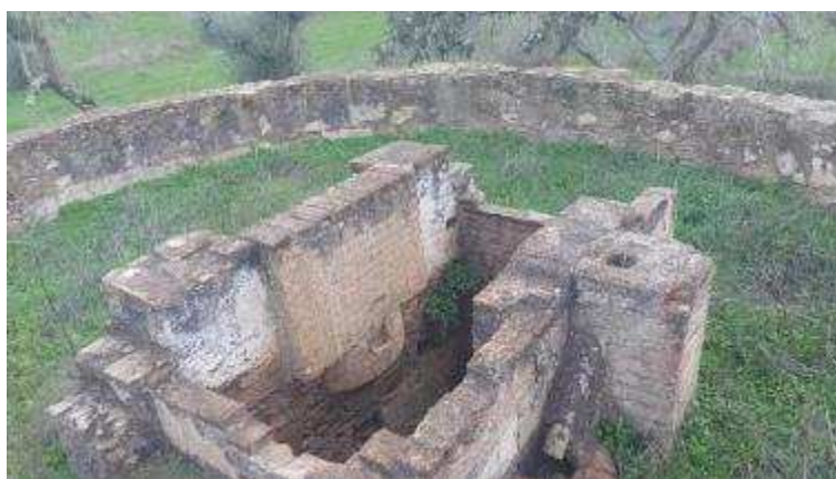
Figura 44. Estrutura poço romano, Alandroal, 2022.
