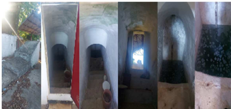
Figura 30. Entrada aqueduto/galeria subterrânea, Vila das Mártires, 2023.
