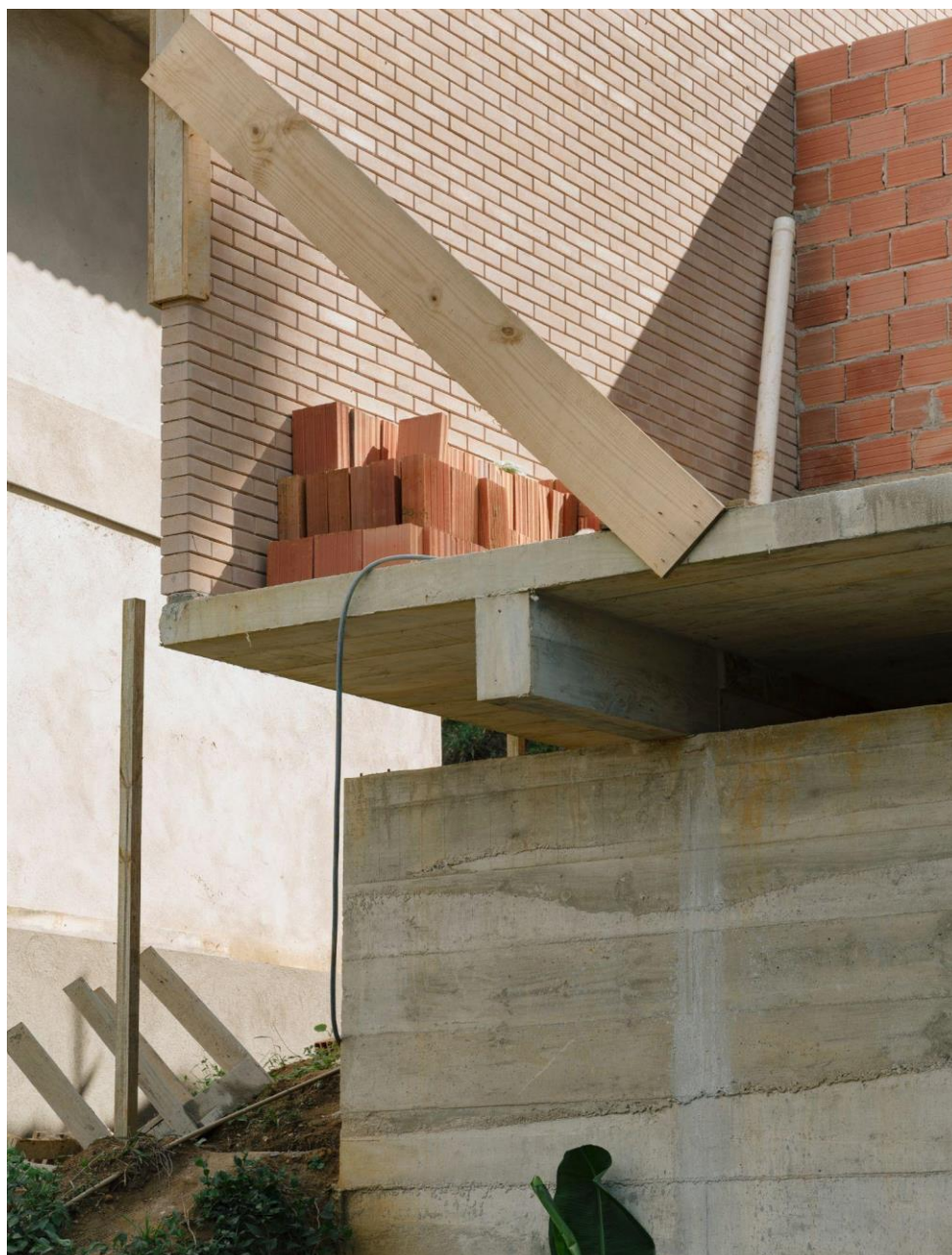
Figura 4 - Escora de obra da casa Vargem Grande (Foto: Federico Cairolì).
