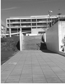
Escadaria de acesso a bloco de aulas
