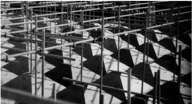
Construção da cobertura - Pormenor das entradas de luz
