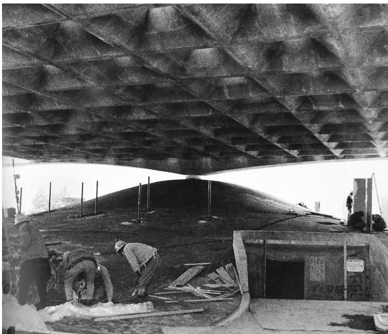
Fig. 7 Construção do Pavilhão do Brasil em Osaka, Paulo Mendes da Rocha, 1969
