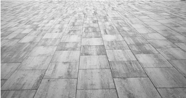
Lajetas de betão branco - Pavimento da plataforma
