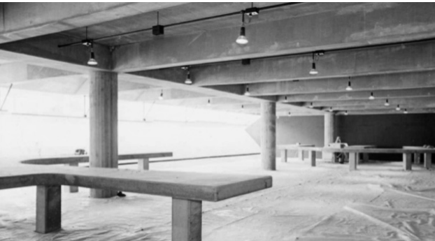
Construção dos balcões de atendimento
