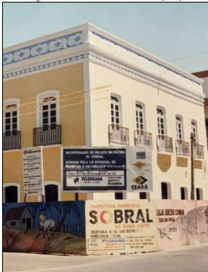
Figura 6 – Casa da Cultura em reforma (1997)
