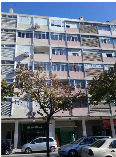
Figura II: Edifício na Avenida Almirante Reis, 94
