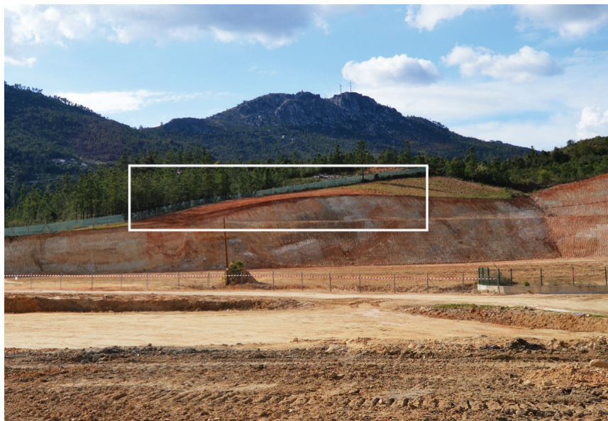
Localização de Cobrinhos já depois dos trabalhos de escavação arqueológica estarem terminados e durante a fase de escavação para a a ampliação da fábrica AMS-BR.
