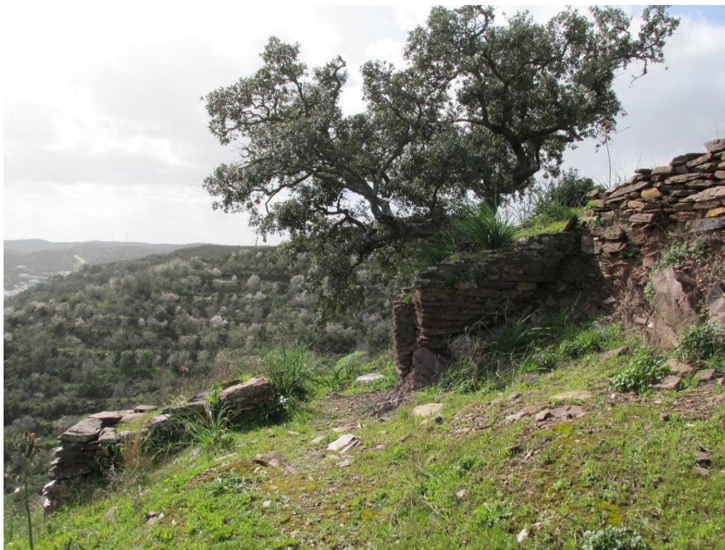
Imagem nº 37 – Entrada do castelo. Estrutura da última fase de ocupação que passou a assemelhar-se com uma grande torre oca, com portas duplas e passagem em «L». Carlos Esquetim, 2017.
