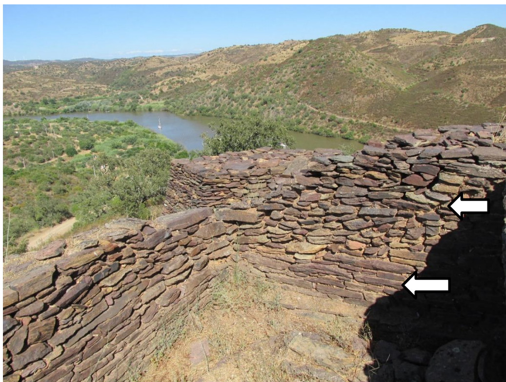
Imagem nº 25 – Pano de muralha onde podemos verificar diferentes métodos de aparelho. Carlos Esquetim, 2015.
