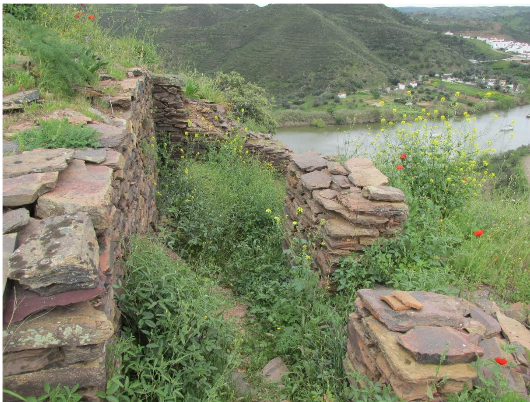
Imagem nº 38 – Vista para o exterior da entrada do castelo, verifica-se que estas paredes têm uma elevação muito superior nestes pontos devido à volumetria dos derrubes, só justificável pela presença de portas. Carlos Esquetim, 2017.
