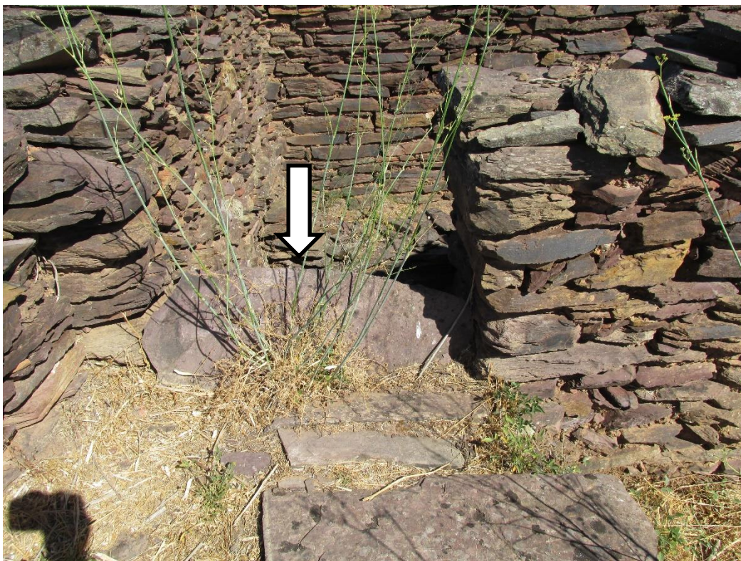
Imagem nº 32 – Placa lítica horizontal com dimensão considerável, colocada na soleira da porta para evitar a entrada das águas pluviais e possíveis animais. Carlos Esquetim, 2015.
