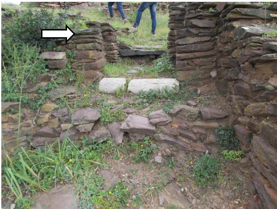
Imagem nº 16 – No interior da estrutura, a porta que dá para o interior do castelo. Carlos Esquetim, 2016.
