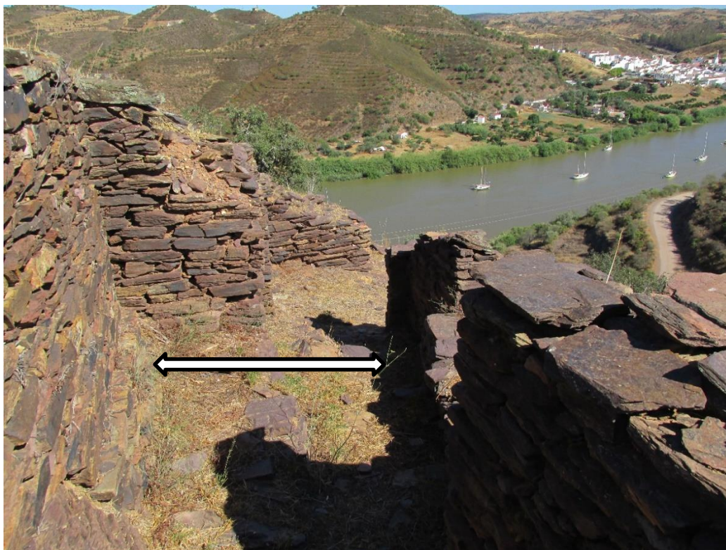
Imagem nº 30 – Complexo defensivo da porta de entrada do alcácer com vista para o exterior, com indicação do espaço que era ocupado pela porta. Carlos Esquetim, 2015.
