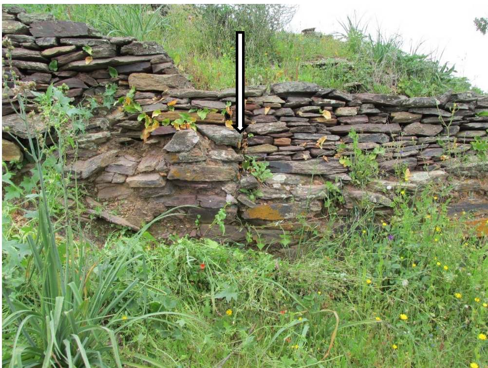
Imagem nº 35 – Quebra na continuidade da muralha vista do tramo a este. Carlos Esquetim, 2017.
