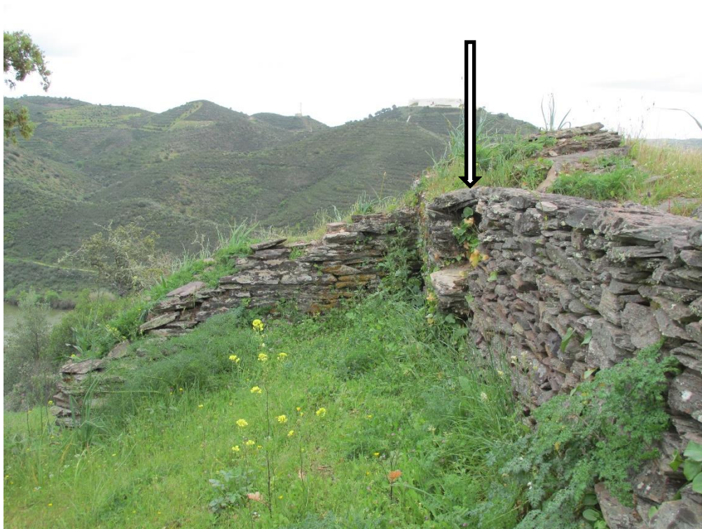
Imagem nº 34 – Torre localizada na muralha externa no ângulo nordeste. Verifica-se uma menor erosão dos materiais mais expostos e uma quebra na continuidade da muralha, indicando ser uma obra posterior (face norte). Carlos Esquetim, 2017.
