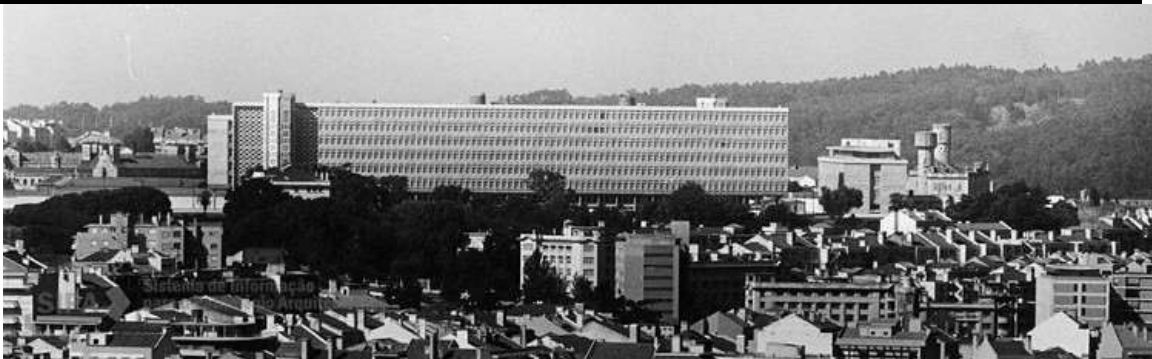
Figure 9 – Palácio da Justiça in Lisbon, n.d. Source: SIPA/Forte de Sacavém.
