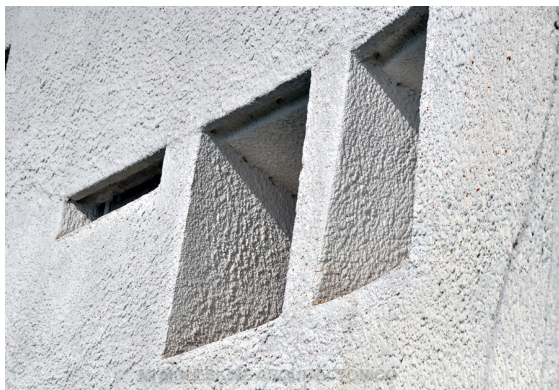
39. Pormenor do exterior da capela de Ronchamp.
