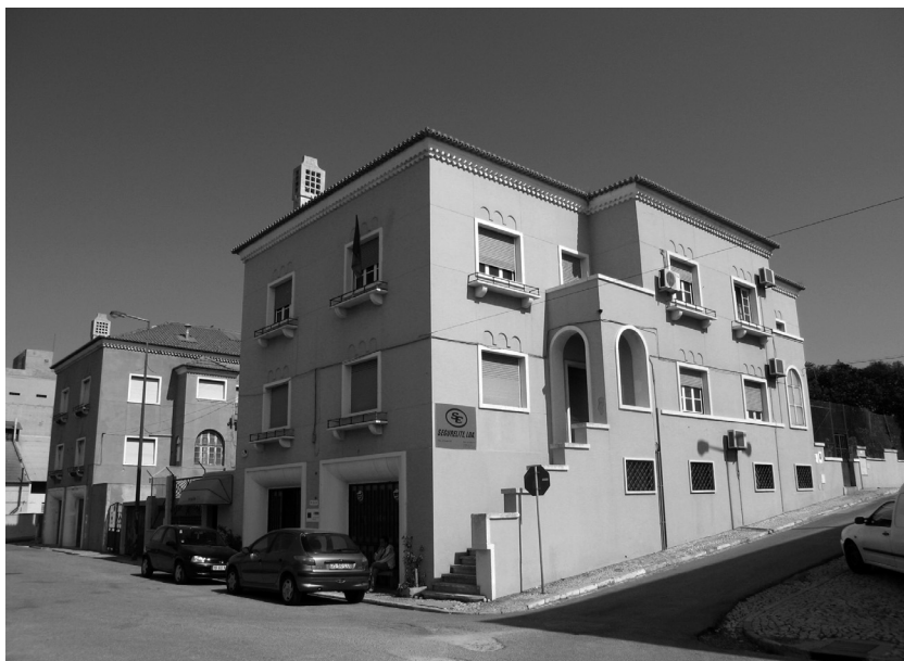
Fig. 2 – Moradia germinada no Bairro de S. Bárbara
