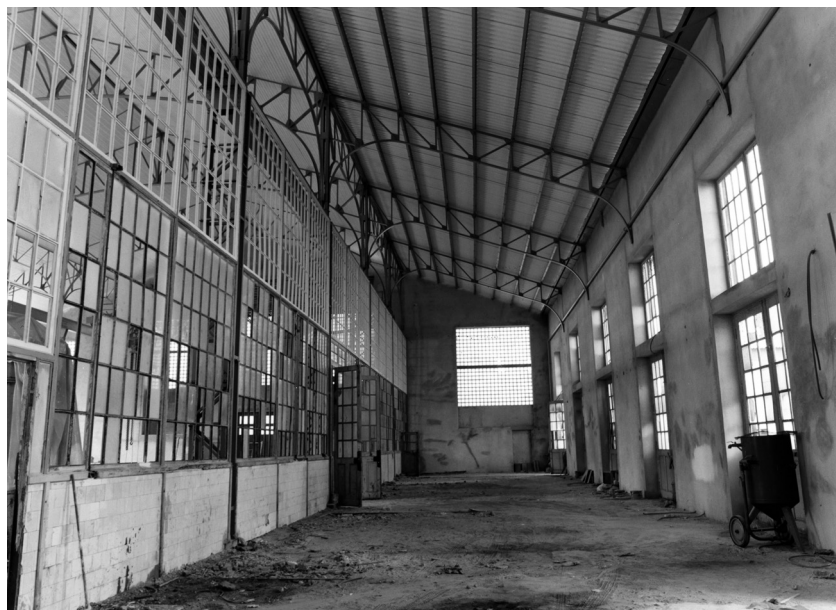
Fig. 6 – Vista interior lateral da nave que ilustra o estado de degradação antes da intervenção
