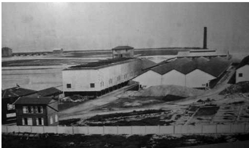
Fig. 2 – A fábrica de Honfleur (fotografia de 1903): à esquerda, a fábrica de ácido sulfúrico, à direita a produção e o parque de superfosfatos
