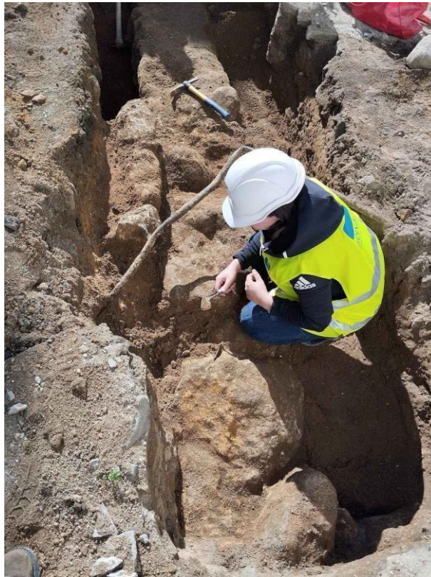
Imagem 10 - Fotografia dos trabalhos na Arrentela.
