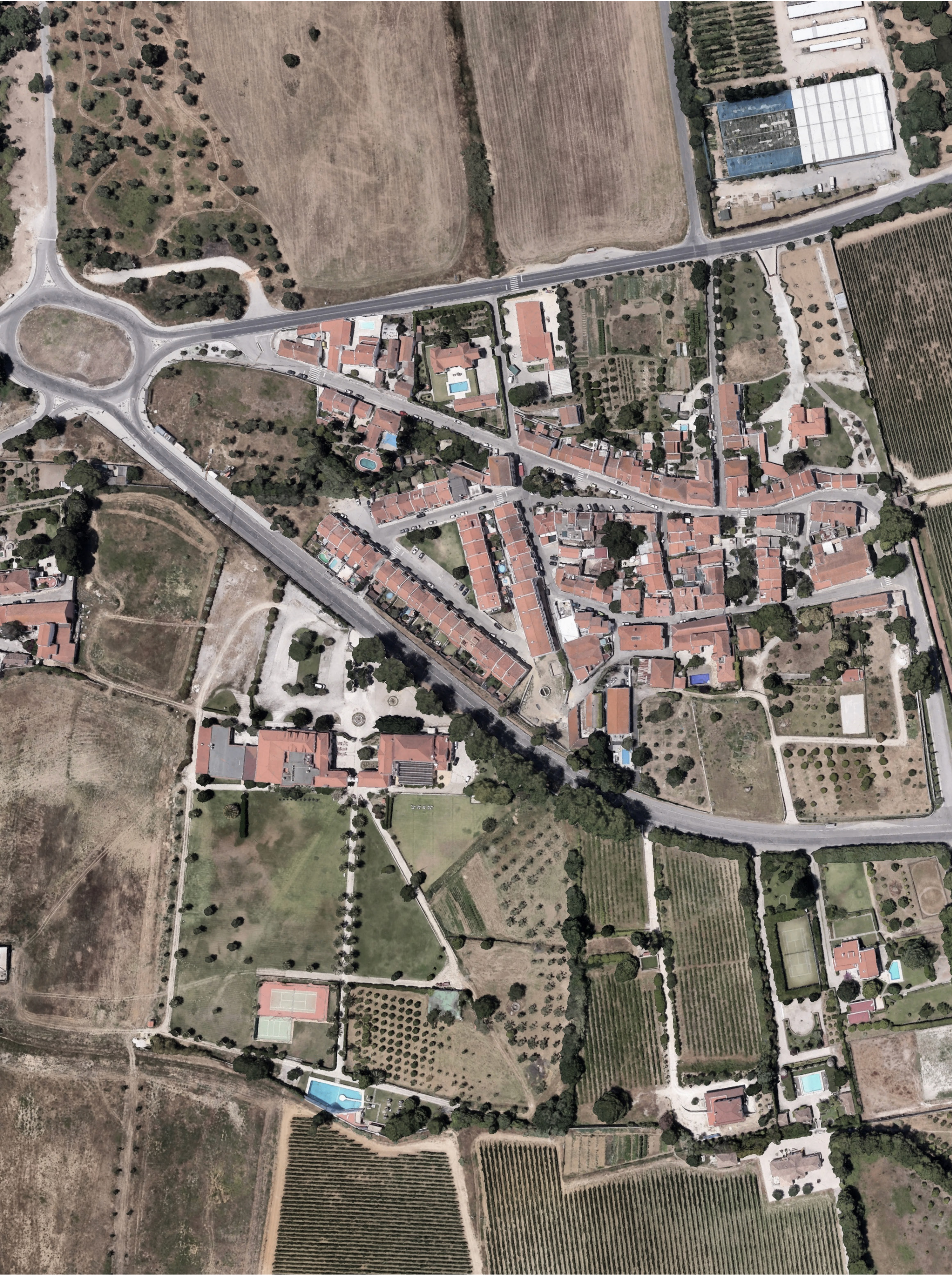
LOCAL DE INTERVENÇÃO Uma Casa Dupla a partir da Casa em Azeitão, 2003
