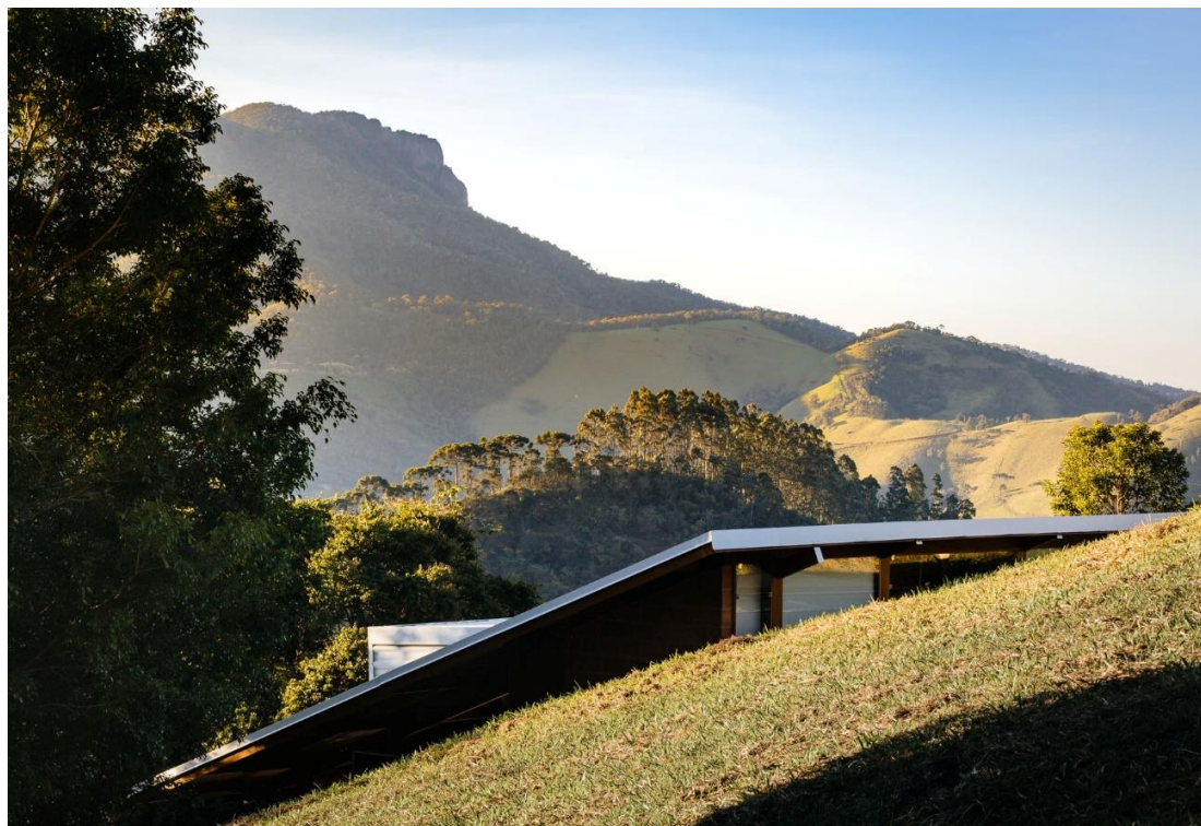
Figura 1 - Casa da meia encosta (Foto: Pedro Kok).
