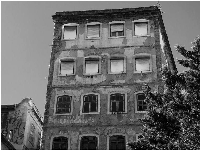
IMG 44 | EDIFÍCIO DEVOLUTO, BECO DO FÉLIX
