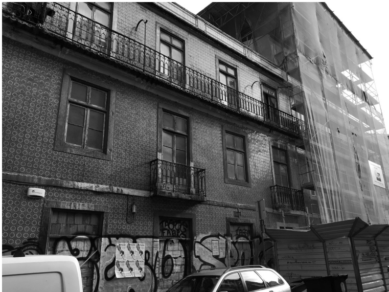
IMG 45 | EDIFÍCIO EM RECUPERAÇÃO, CALÇADA DO DESTERRO
