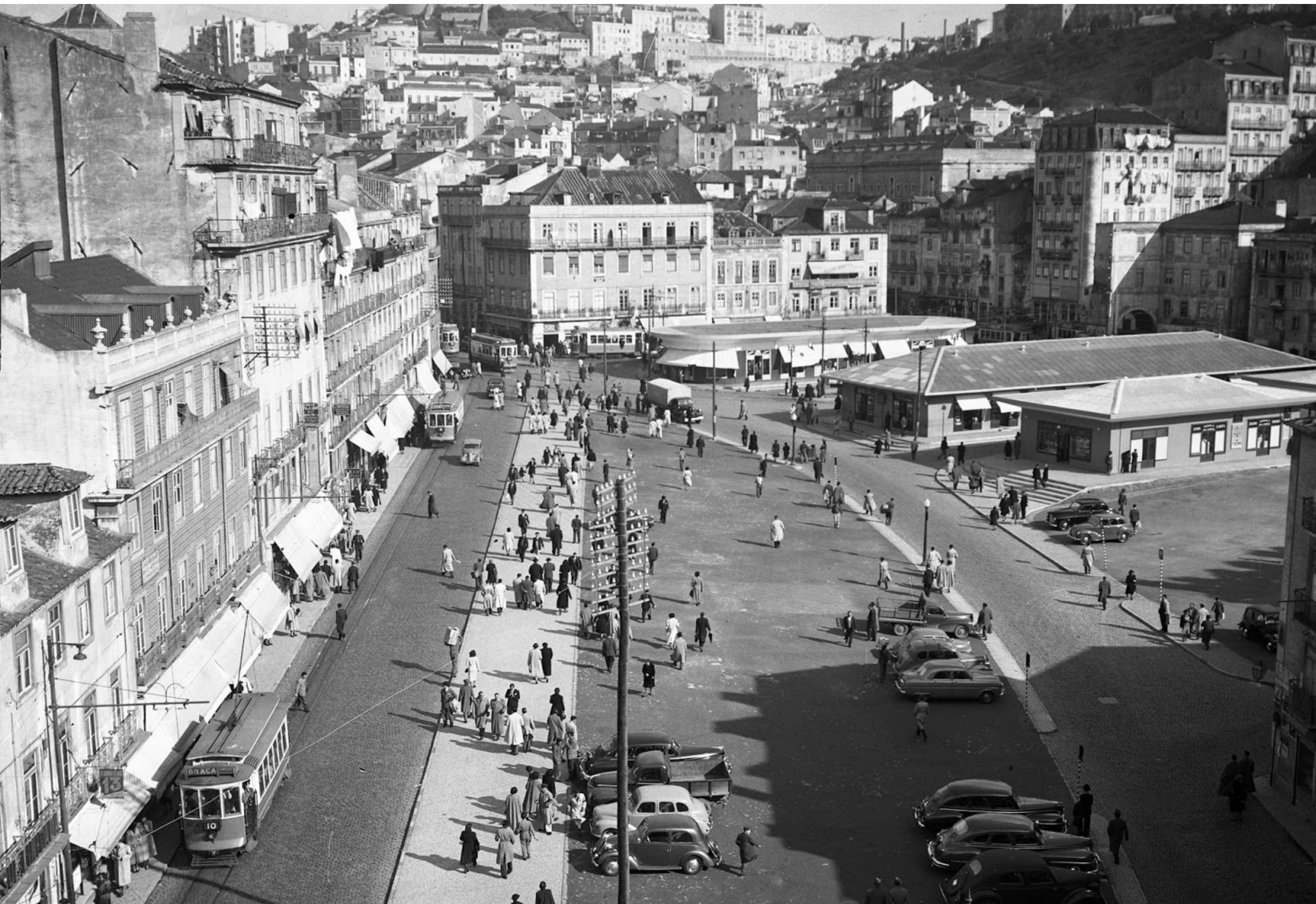
ÍMG 04 | RUA DA PALMA, DEPOIS DAS DEMOLIÇÕES | 1952
