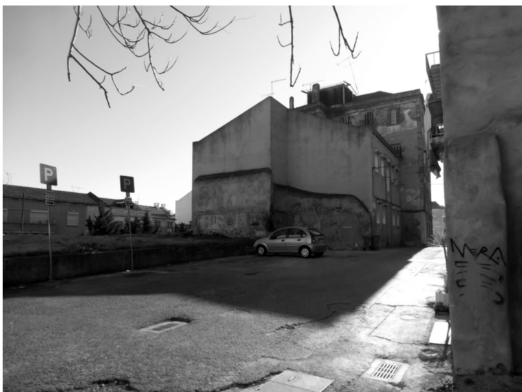
IMG 78 | RUAS DAS BARRACAS | ESTA FOTOGRAFIA MOSTRA A DEGRADAÇÃO E O ABANDONO A QUE CHEGOU O TOPO DA RUA DAS BARRACAS, SENDO POR ISSO PRECISO UMA INTERVENÇÃO URGENTE NESTE LOCAL.
