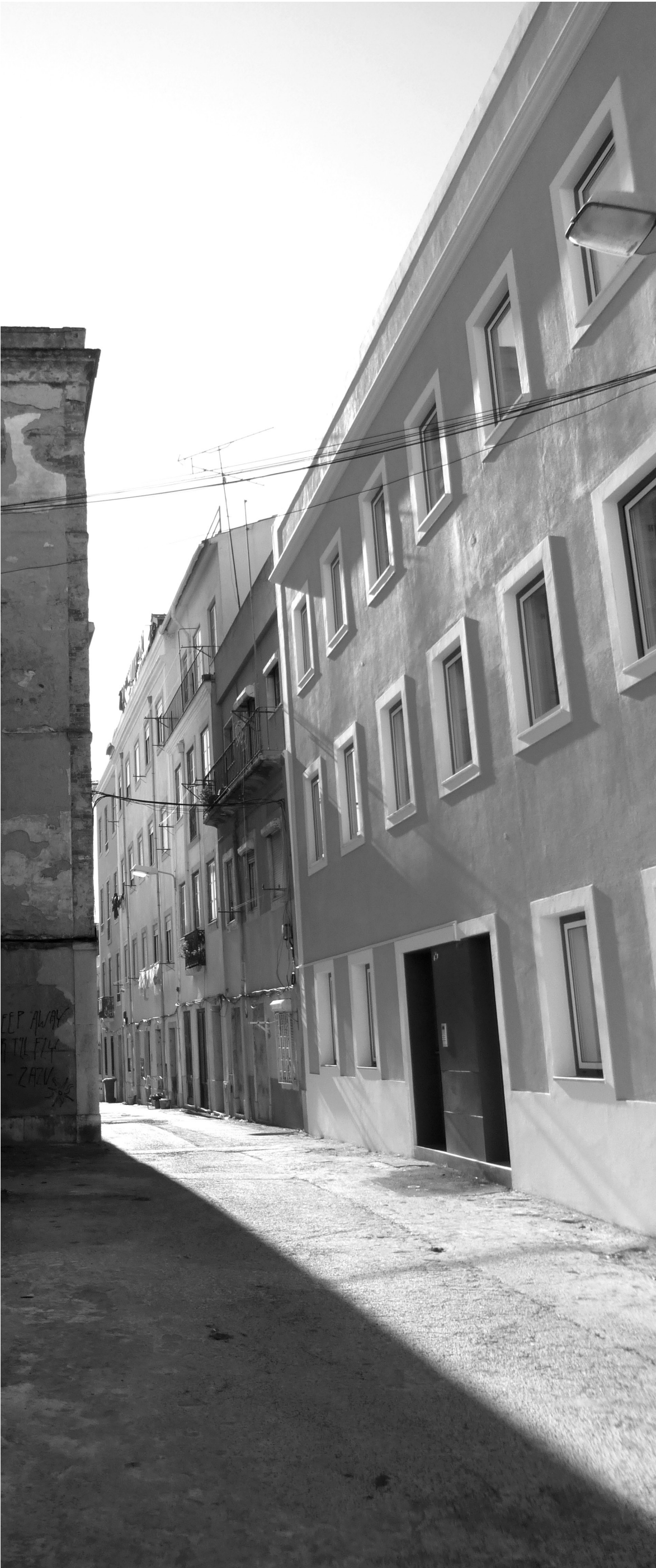
IMG 83 | ARRUAMENTO, RUA DAS BARRACAS
