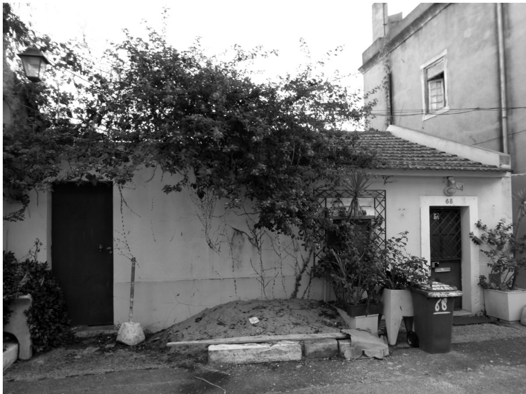
IMG 56 | RUA DAS BARRACAS
