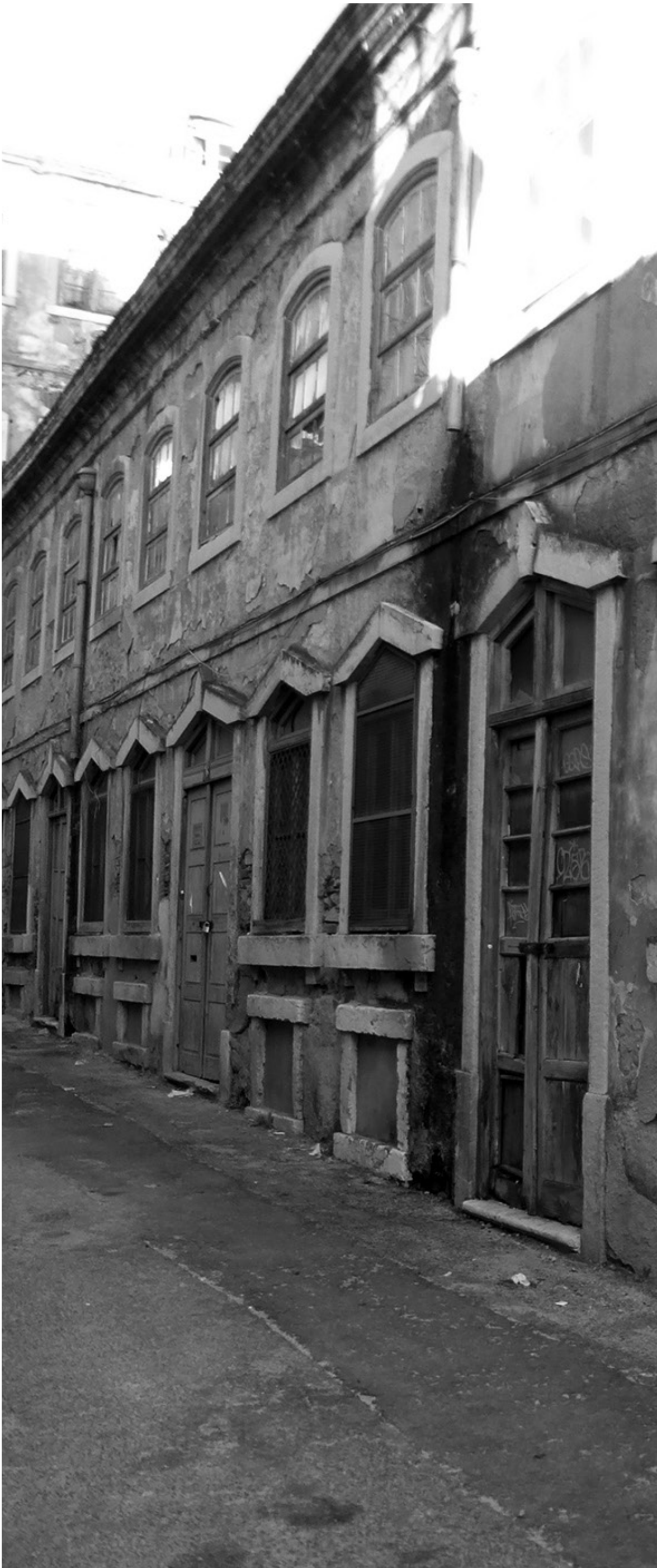
IMG 47 | EDIFÍCIO DEVOLUTO DA ANTIGA FÁBRICA DOS TECIDOS, RUA DAS BARRACAS
