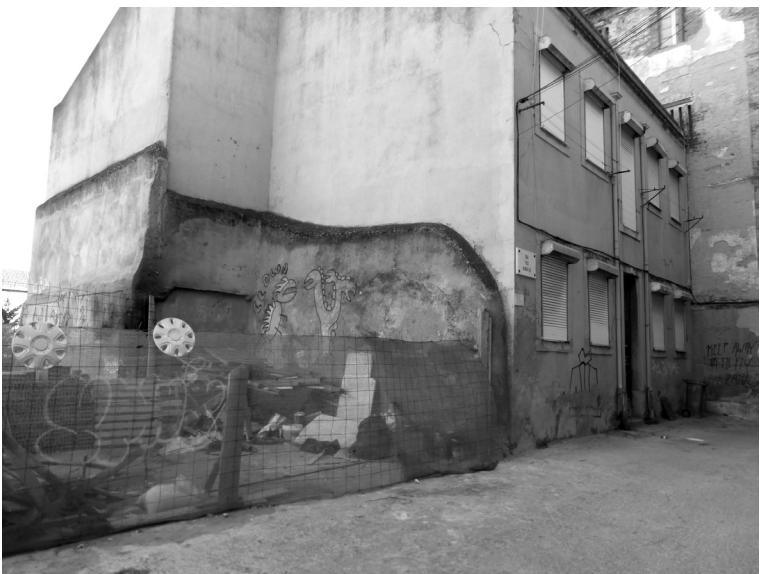
Img 69 | Rua das Barracas
