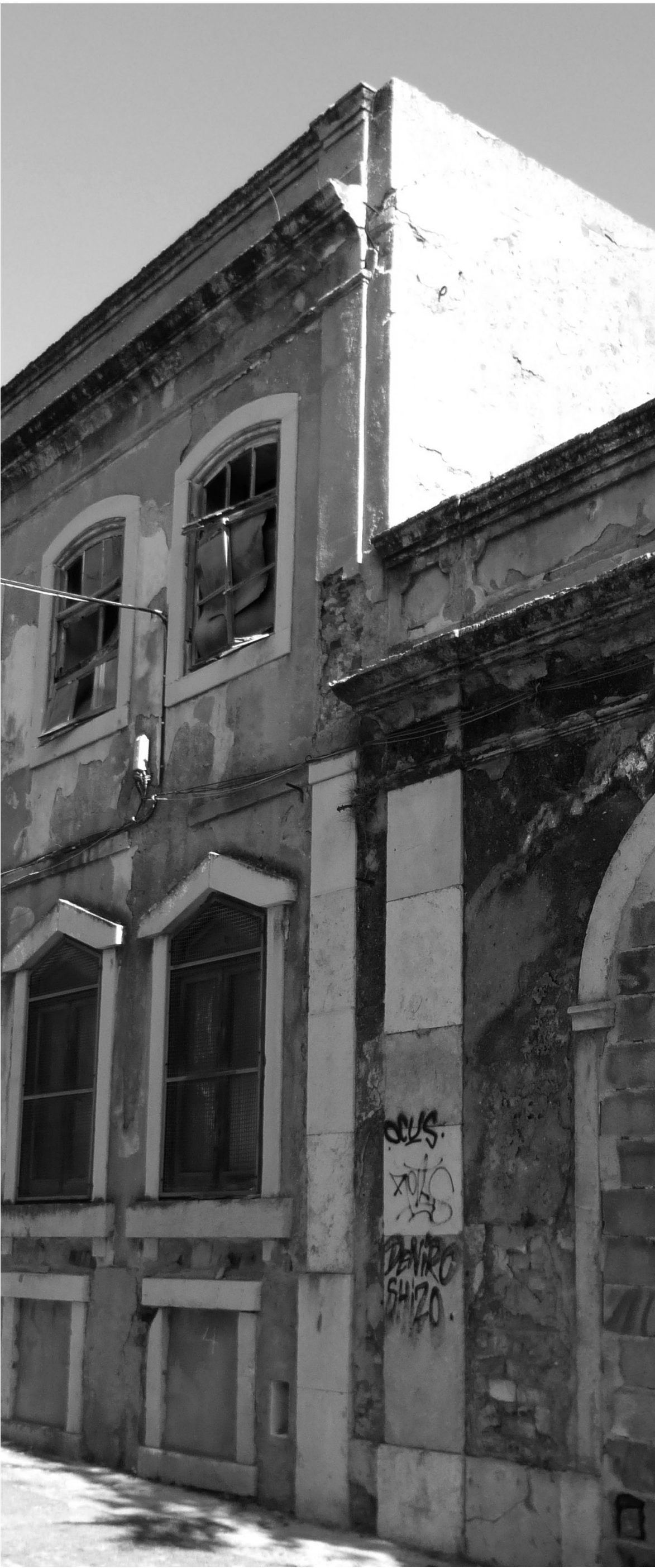
IMG 73 | DETALHE DA ANTIGA FÁBRICA DOS TECIDOS, RUA DAS BARRACAS
