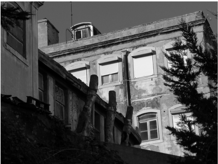
Img 67 | Edifício devoluto, Rua das Barracas
