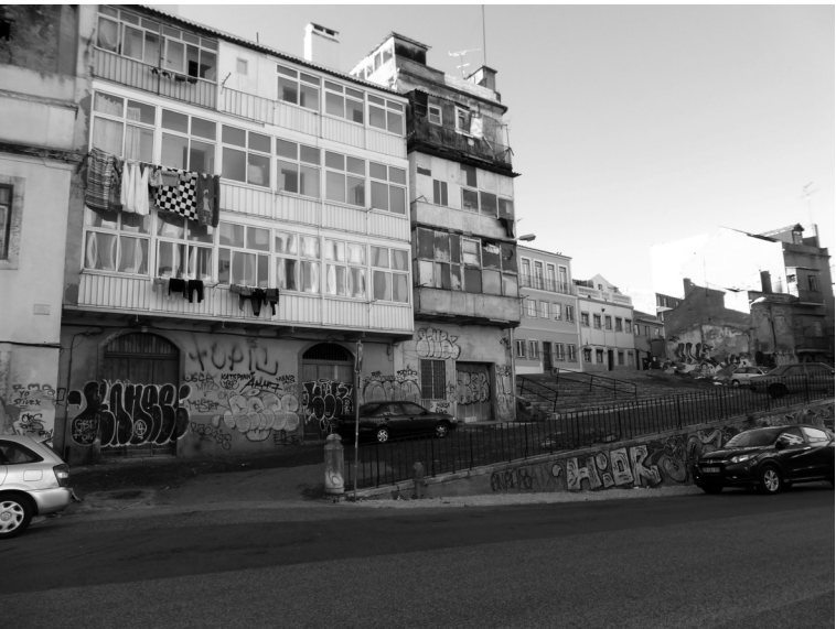
IMG 62 | ZONA DE CONFLITO URBANO, RUA SANTA BÁRBARA
