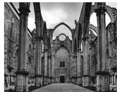
Imagem 007 | Arquitectura Convento do Carmo
