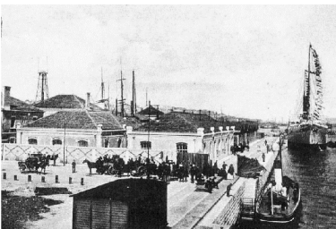
Imagem 103 Linha de Costa | Cais do Sodré
