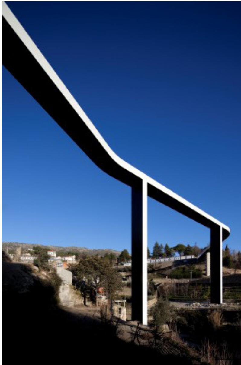
10.Fotografia. Ponte do Vale da Carpinteira. Covilhã.
