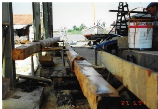
Troncos preparados para a colocação dos vaus. Fonte: Celso Santos.
