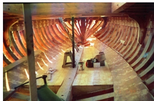
Vista do interior, colocação de cavaletes para nivelar. Fonte: Celso Santos.
