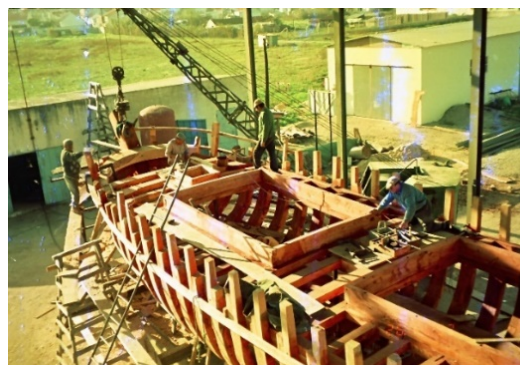
Montagem das braçolas do porão. Fonte: Celso Santos.
