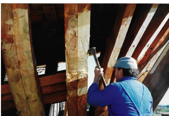
Aparagem das cavernas, para receber o tabuado. Fonte: Celso Santos.
