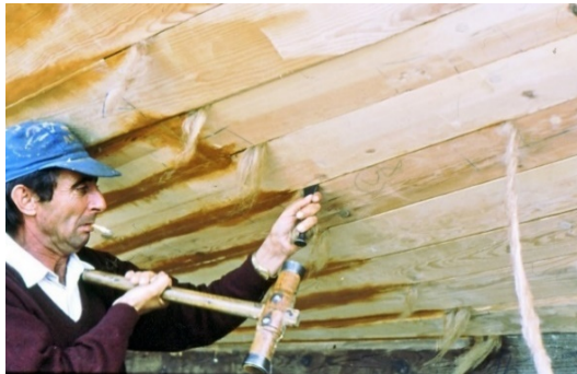
Colocação da estopa no tabuado. Fonte: Celso Santos.
