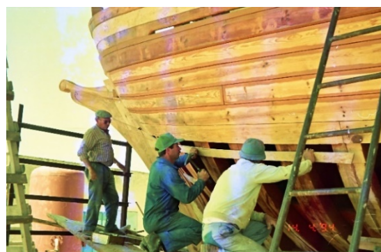
Colocação do tabuado. Fonte: Celso Santos.
