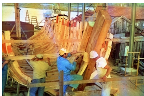
Execução do travamento da caverna, proa. Fonte: Celso Santos.
