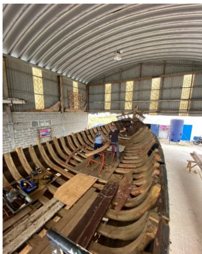
Figura 52. Ricardo Costa com um funcionário. Colocação das cavernas. Fonte: estaleiro naval de Jaime Costa.
