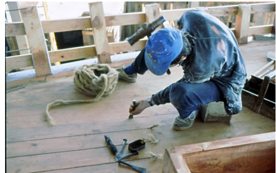
Colocação da estopa no convés. Fonte: Celso Santos.
