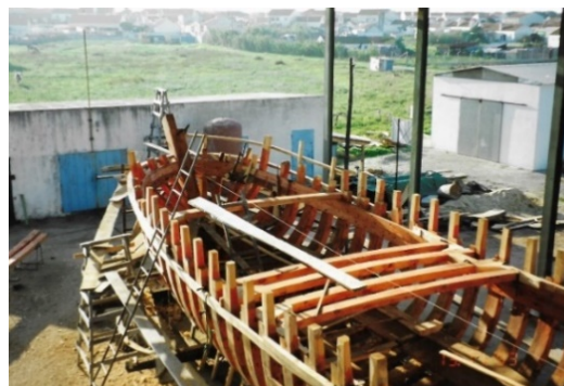
Montagem dos vaus e bancos. Fonte: Celso Santos.
