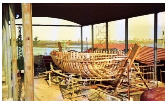
Travamento concluído. Fonte: Celso Santos.
