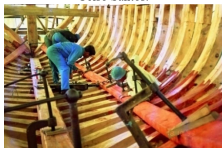
Escoas. Tábua na longitudinal no encolamento do barco (3) de cada lado-Fonte: Celso Santos.
