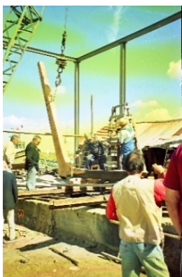
Montagem da roda da proa na quilha. Fonte: Celso Santos.
