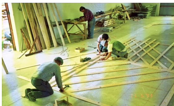
Figura 16. Construção da grade em cima da esquadria desenhada no chão. Fonte: Celso Santos.
