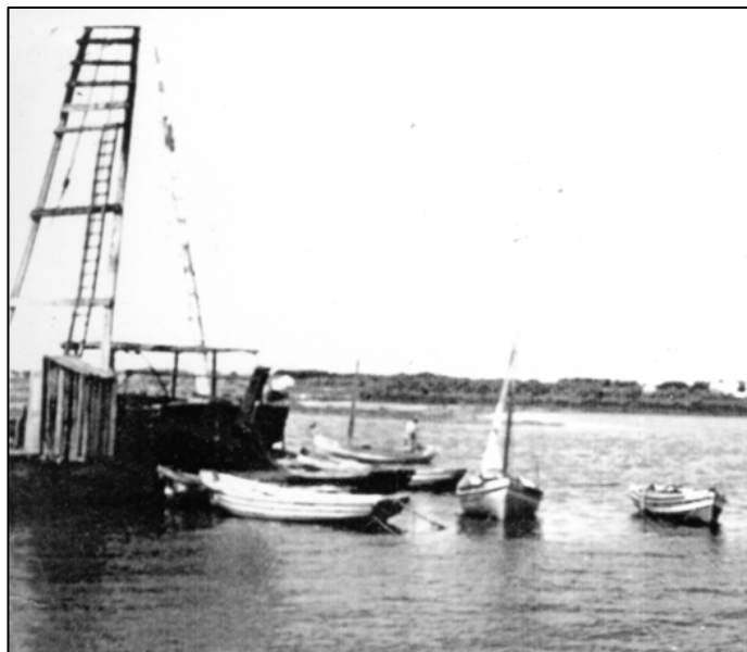
Figura 4. Cábrea do estaleiro naval de Sarilhos Pequenos a retirar o mastro de uma fragata. Anos 60.
