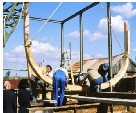
Montagem da caverna mestra. Fonte: Celso Santos.
