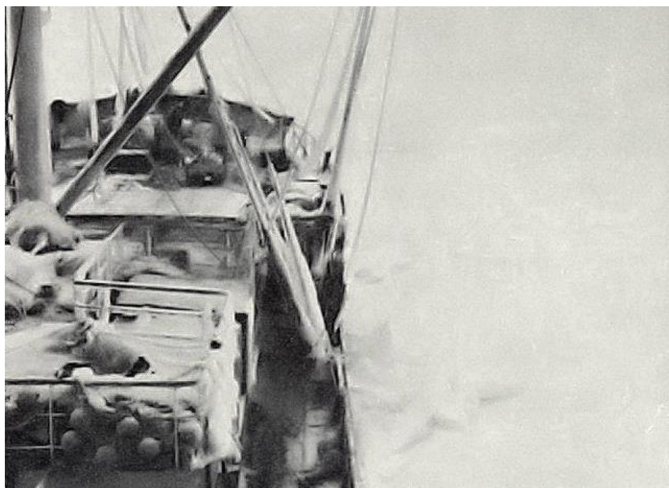
Fig. n.º 42, Fotografia tirada a bordo de um lugar bacalhoeiro, na Terra-Nova, preso no gelo 199 , onde pode ser visto o interior do convés principal e parte do castelo de proa.
