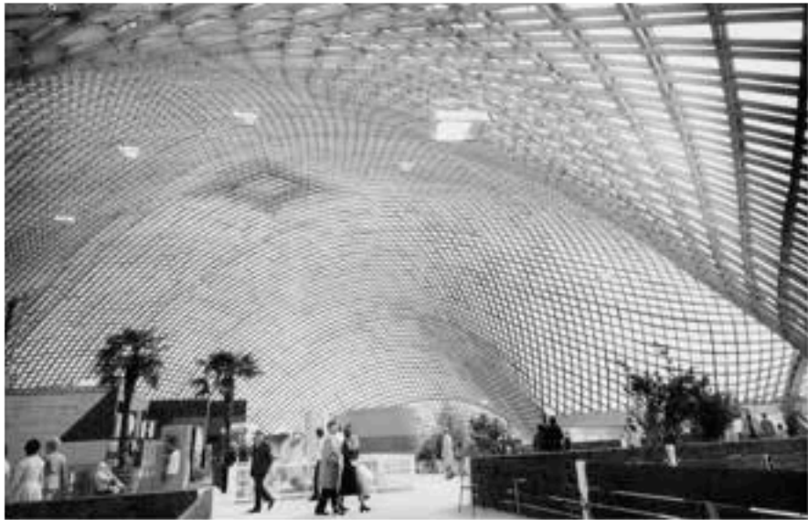
Estrutura autoportante de capas de ripas de madeira / Mannheim Multihalle / Frei Otto © Daniel Lukac
