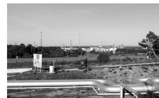
Fig. 35 | Rua Direita | Interruzione del percorso | Pipelines
