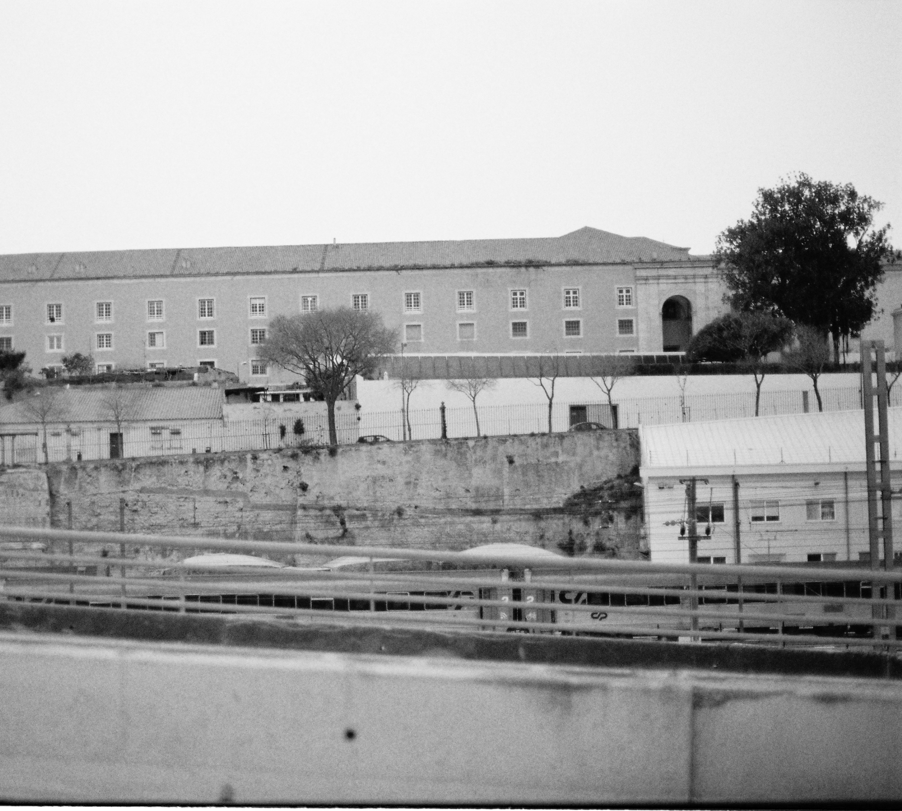
Convento de Santos-o-Novo, muro de contenção actual na Calçada da Cruz da Pedra e a actual infraestrutura de apoio à estação de Santa Apolónia.
