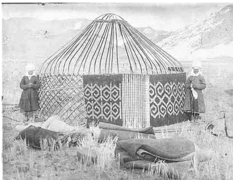
Fig.12 Estrutura de um yurt
