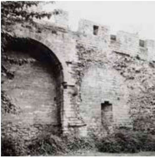
02. A Tour de Villers mostra as arcadas e bases originais bastante desobstruídas, sendo que foi incorporado um pequeno espaço público junto deste troço da muralha.
