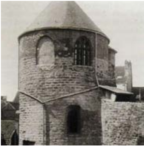
03. A Tour Anneessens, junto ao Boulevard de l'Empereur, é um dos vestígios mais completos da muralha. Tem duas extensões de parede da muralha para ambos os lados da torre, formando uma construção com forma de "L". É construída em grés, com o último nível reconstruído em tijolo vermelho durante as restaurações posteriores.
