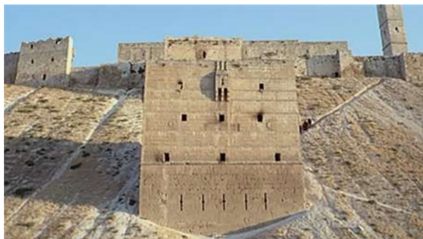
Figura 4: Casa de Medeia no primeiro plano e ao fundo as fortalezas do Castelo de Creon
