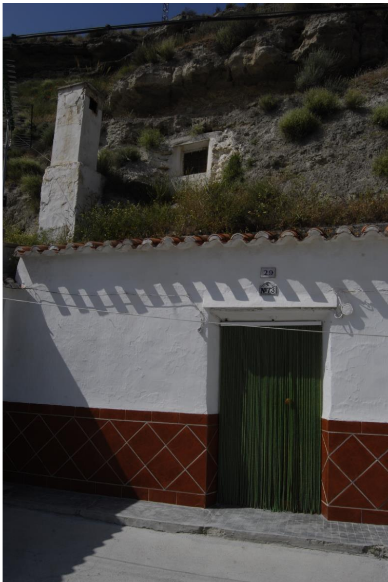
Fig.05 - Fachada de una cueva con zócalo
