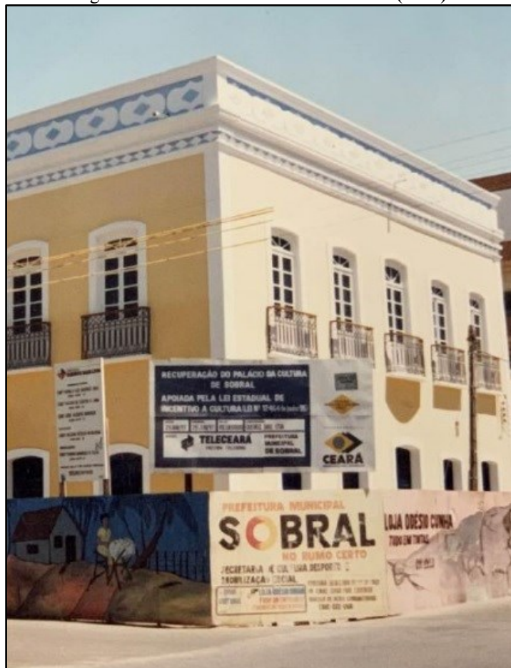
Figura 6 – Casa da Cultura em reforma (1997)
