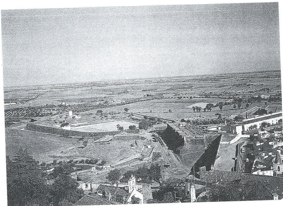
Aspecto da cerca abaluartada da cidade de Elvas (distrito de Portalegre).
