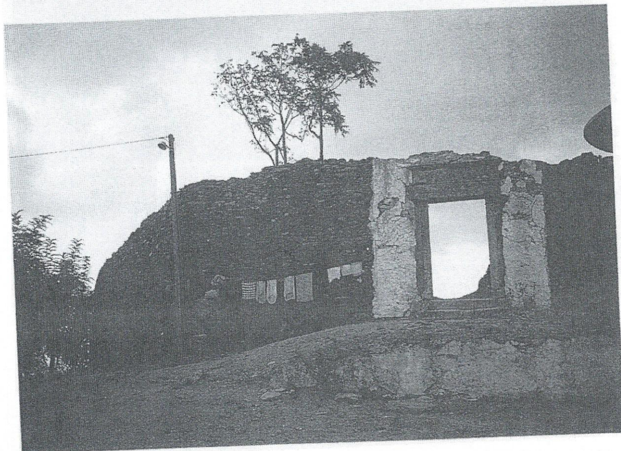
Montalvão – aspecto da cerca arruinada (distrito de Portalegre).
