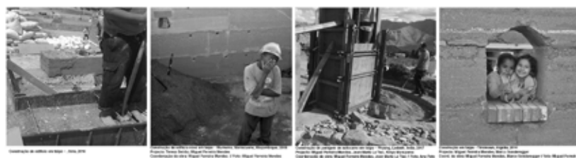
Figura 86. Construção em Taipa
