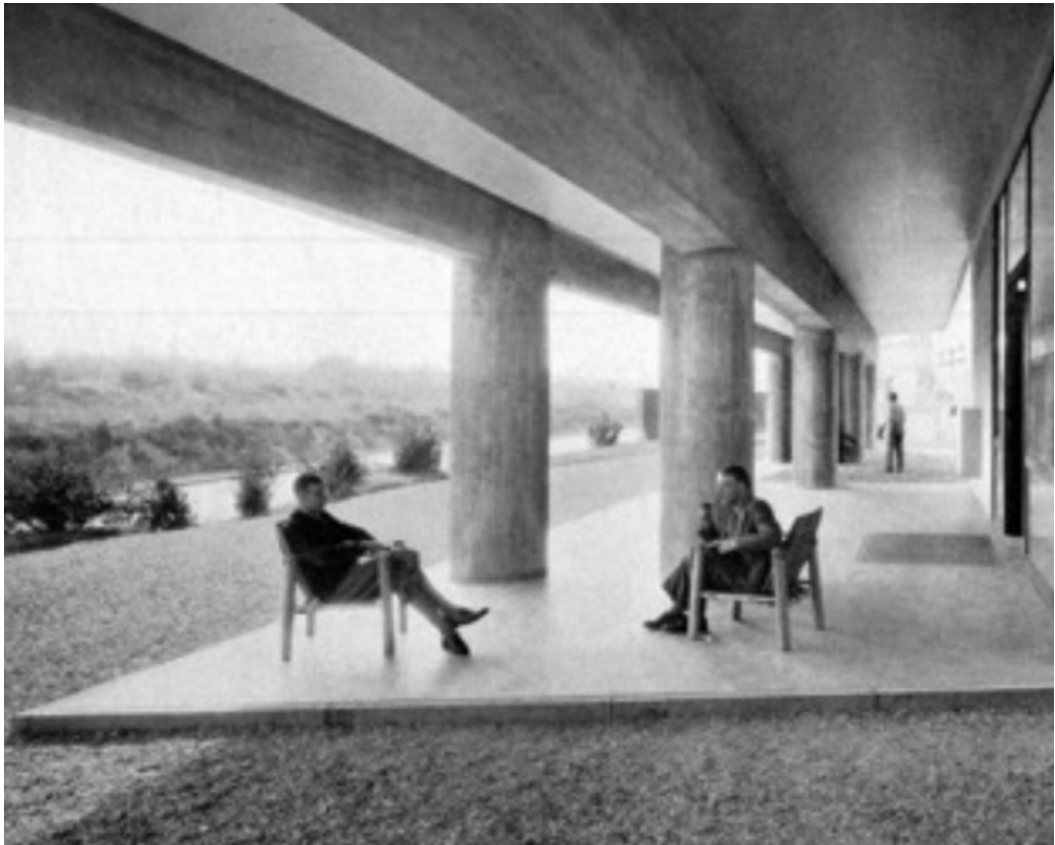
Fig. 002 | Pilotis da Fundação Suiça Cité Universitaire, Le Corbusier
