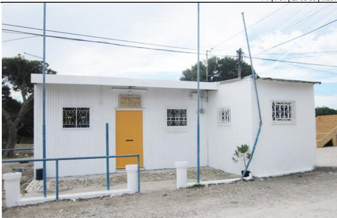
Figura 19 – (5a) Edifício da Associação de Moradores.
