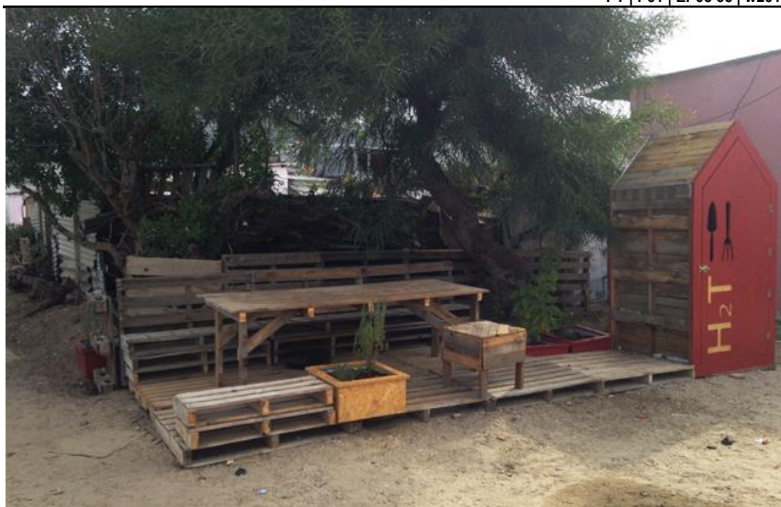
Figura 9 – (3a) Hortas, construção de espaço Público junto à igreja, reutilizando paletes.
