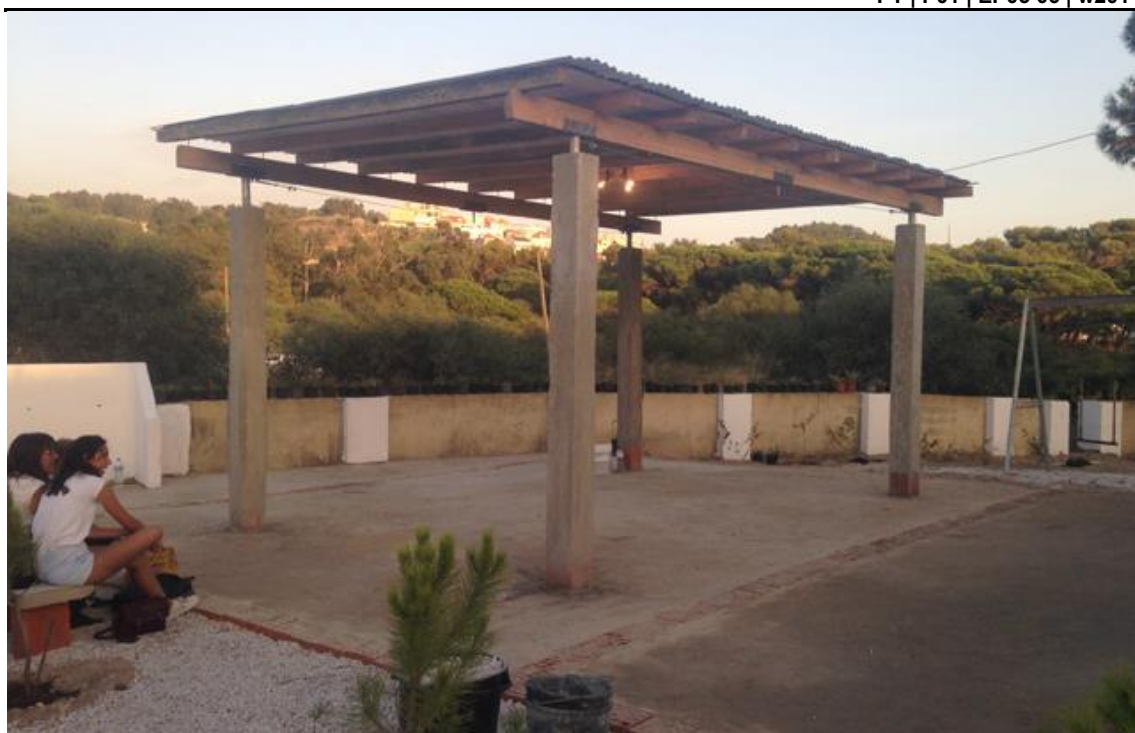
Figura 26 – (2) Espaço lateral à Associação de Moradores. Último dia de construção do InSituAction.
