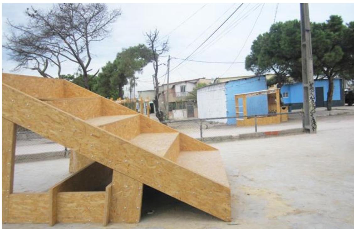
Figura 20 – (5b) Bancada construída no espaço lateral ao edifício da Associação de Moradores. Ao fundo a banca de troca (figura 14) e espaço de encontro (figura 8).
