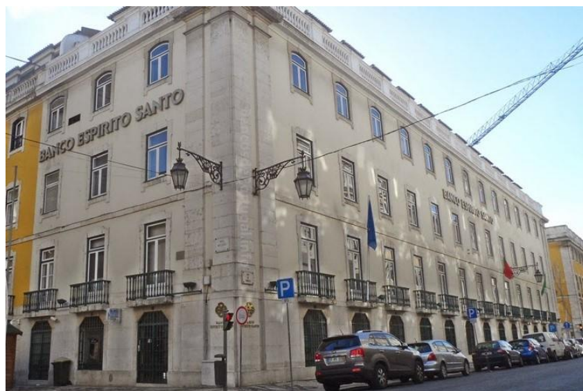
Figura I.3 – Edifício Sede do Banco Espírito Santo na Rua do Comércio
