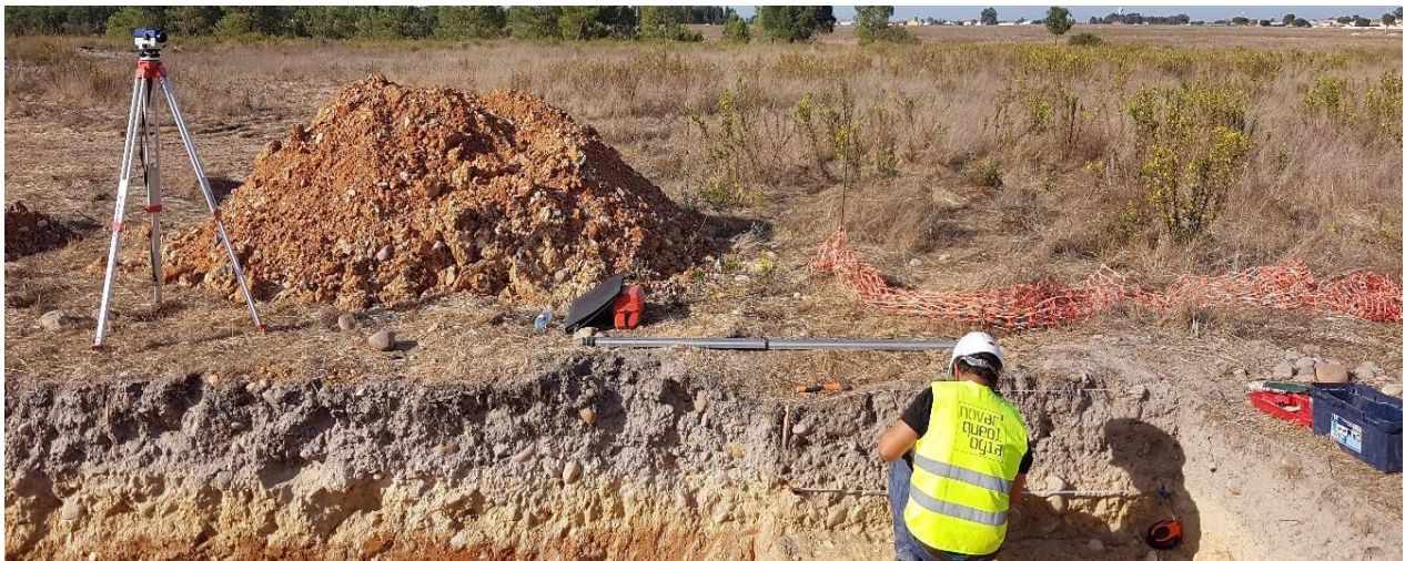
Figura 20: Aspecto dos trabalhos de escavação (Fonte: Idem ).
