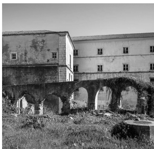
Fig. 69- Fachada oeste do Convento de Chelas.
