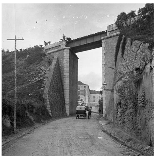
Fig. 68- Viaduto de Chelas, sobre a Estrada de Chelas.
