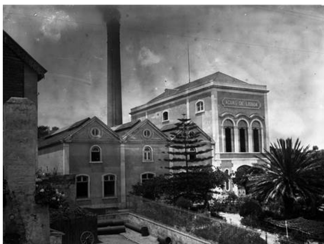
Fig. 24- Fachada da estação elevatória dos Barbadinhos.
