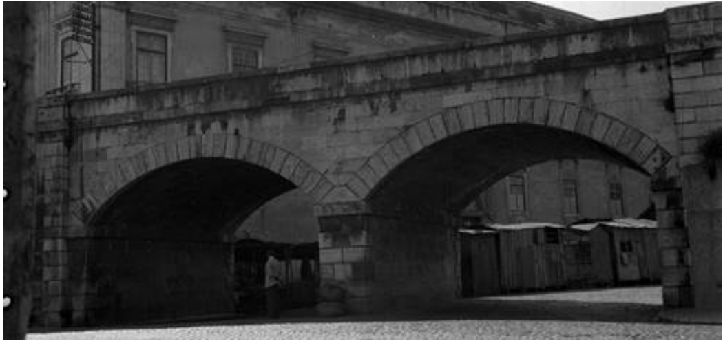
Fig. 60- Arcos do viaduto ferroviário de Xabregas, acesso ao largo do Marquês de Nisa.
