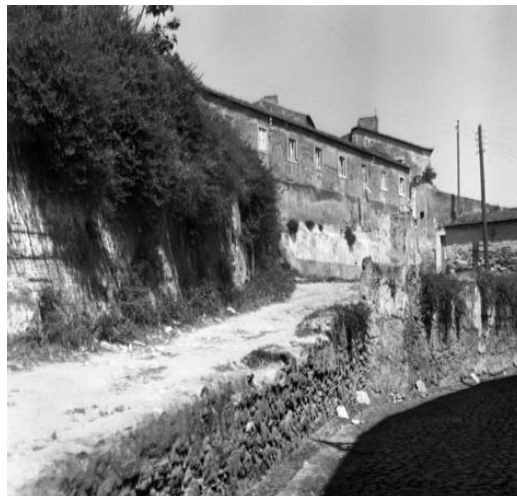
Fig. 65- Extinto Pátio Sete, vista a partir da estrada de chelas.
