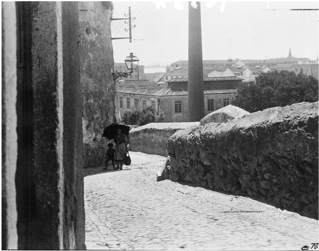
Fig. 72- Fábrica da Samaritana vista a partir do Beco dos Toucinheiros.
