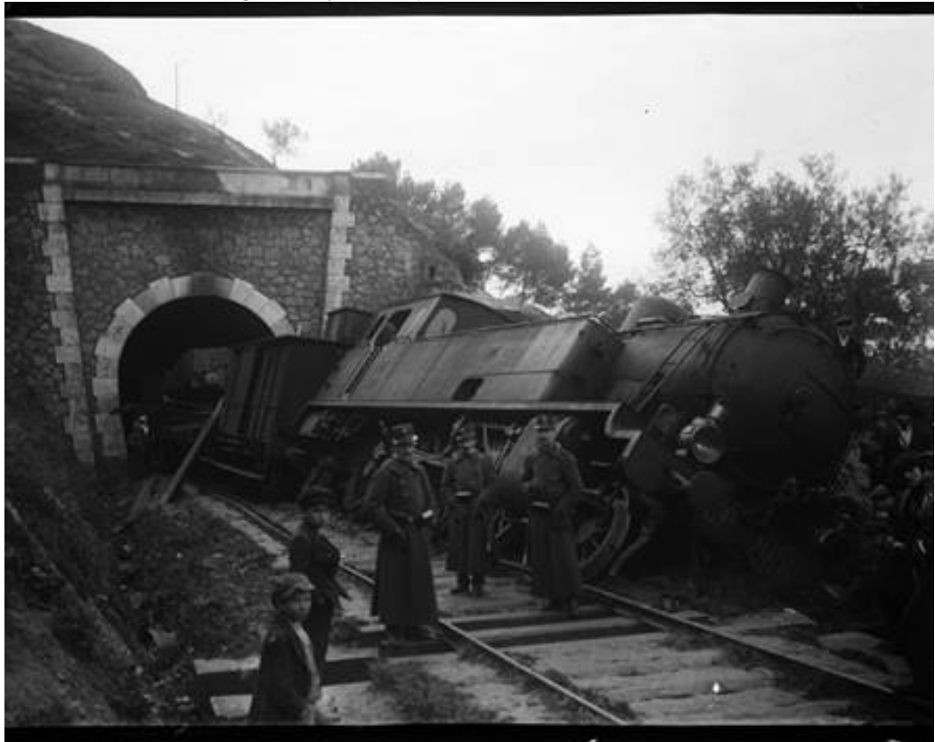
Fig. 50- Túnel da Concordância de Xabregas, comboio descarrilado no ramal ferroviário.
