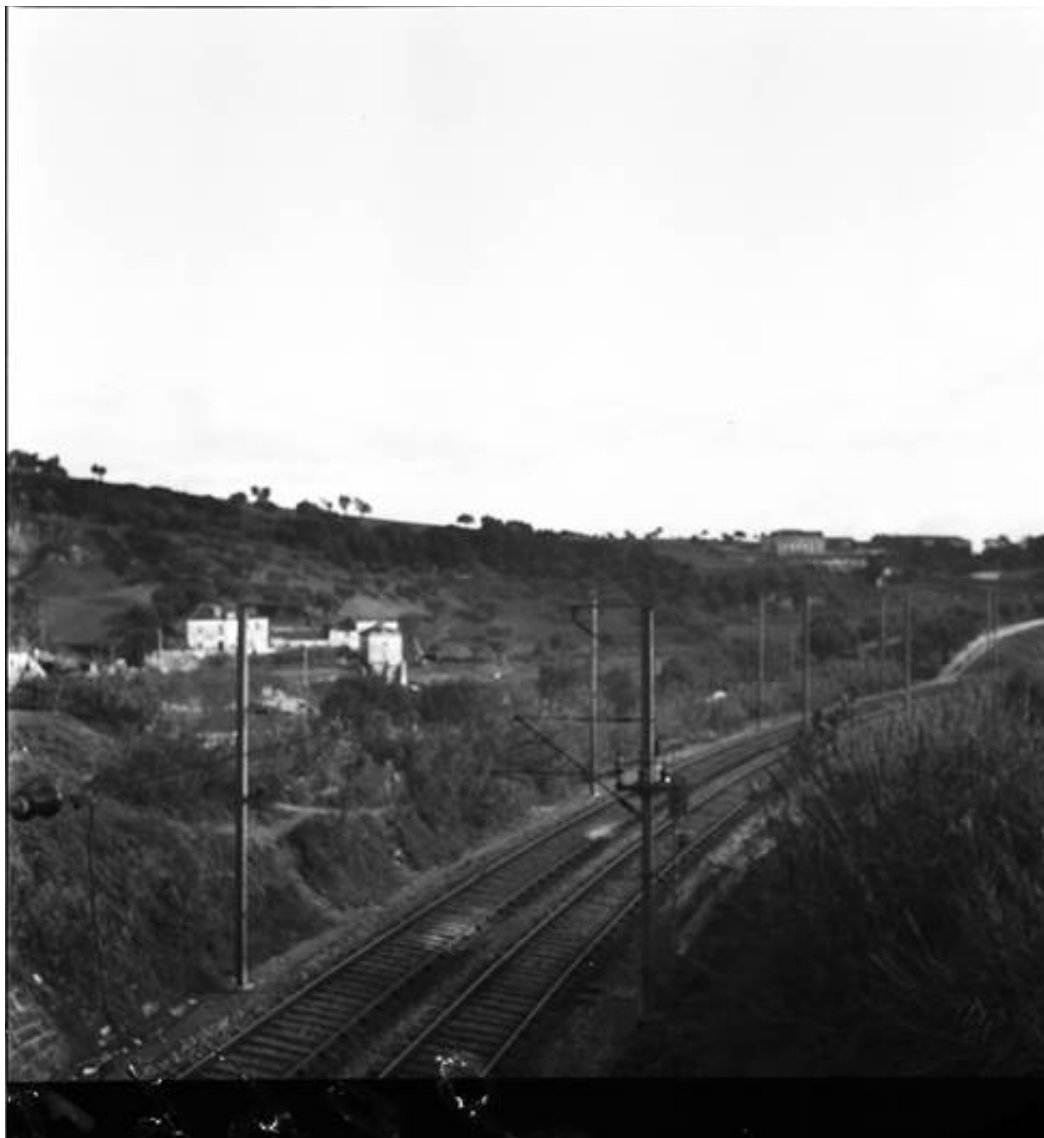
Fig. 3- Linha de cintura, vista a partir do alto da Avenida Almirante Gago Coutinho. A linha de cintura é o eixo que conecta a linha do Leste com a linha de Sintra.
