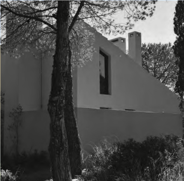
Fotografia do local de intervenção
