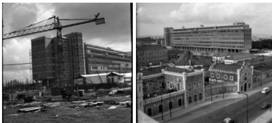
Figura 7 – Construção do Palácio da Justiça de Lisboa, 1969 (Fonte: Arquivo Municipal de Lisboa| (à esquerda) Palácio da Justiça em construção, Artur Inácio Bastos, AIB002260; (à direita) Palácio da Justiça e Penitenciária, Artur Inácio Bastos, A66398).
