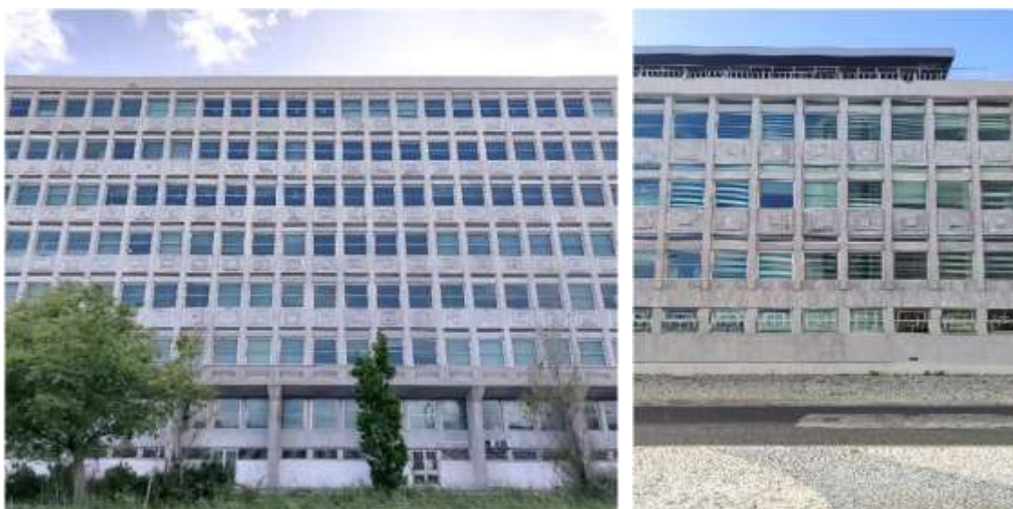
Figura 21 – Elementos das fachadas, 2025 (Fonte: Fotografias da autora, Open House Lisboa).
